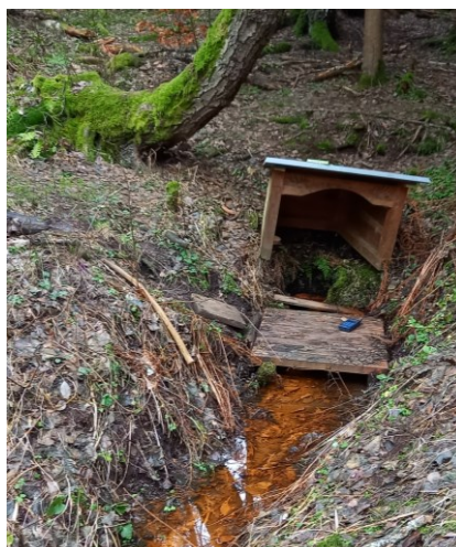
Obr. 59 - Současný stav Srnčího pramene (7.1.2024)
