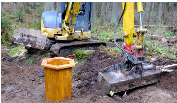
Obr. 47 - Zachycení Maxovy kyselky (Foto: Jiří Milota 21.2.2022)
