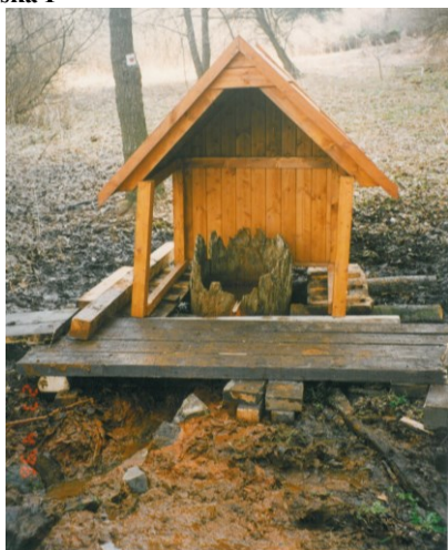
Obr. 52 - Koňská I po rekonstrukci (Foto: Jiří Milota 27.4.1996)
