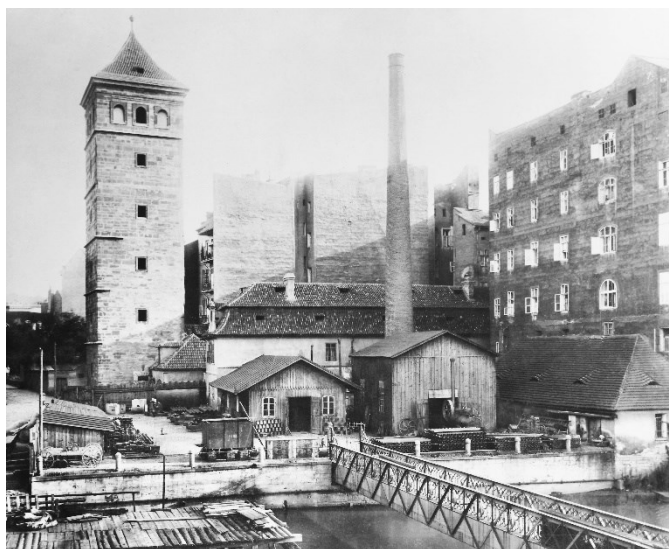
Novomlýnská vodárenská věž a její okolí. Foto Eckert, kol. 1890, AMP, sign. VIII 1066. Zmizelá Praha – Vltava a její břehy: 2. díl., Od Petřské čtvrti po vodě do Troje Praha, Paseka, 2016. Zde vidíme již po odstavu. Břeh mezi věží a lagunou sloužil pile a kovárně, které však pracovaly na parní pohon, což dokládá komín na fotografii.
