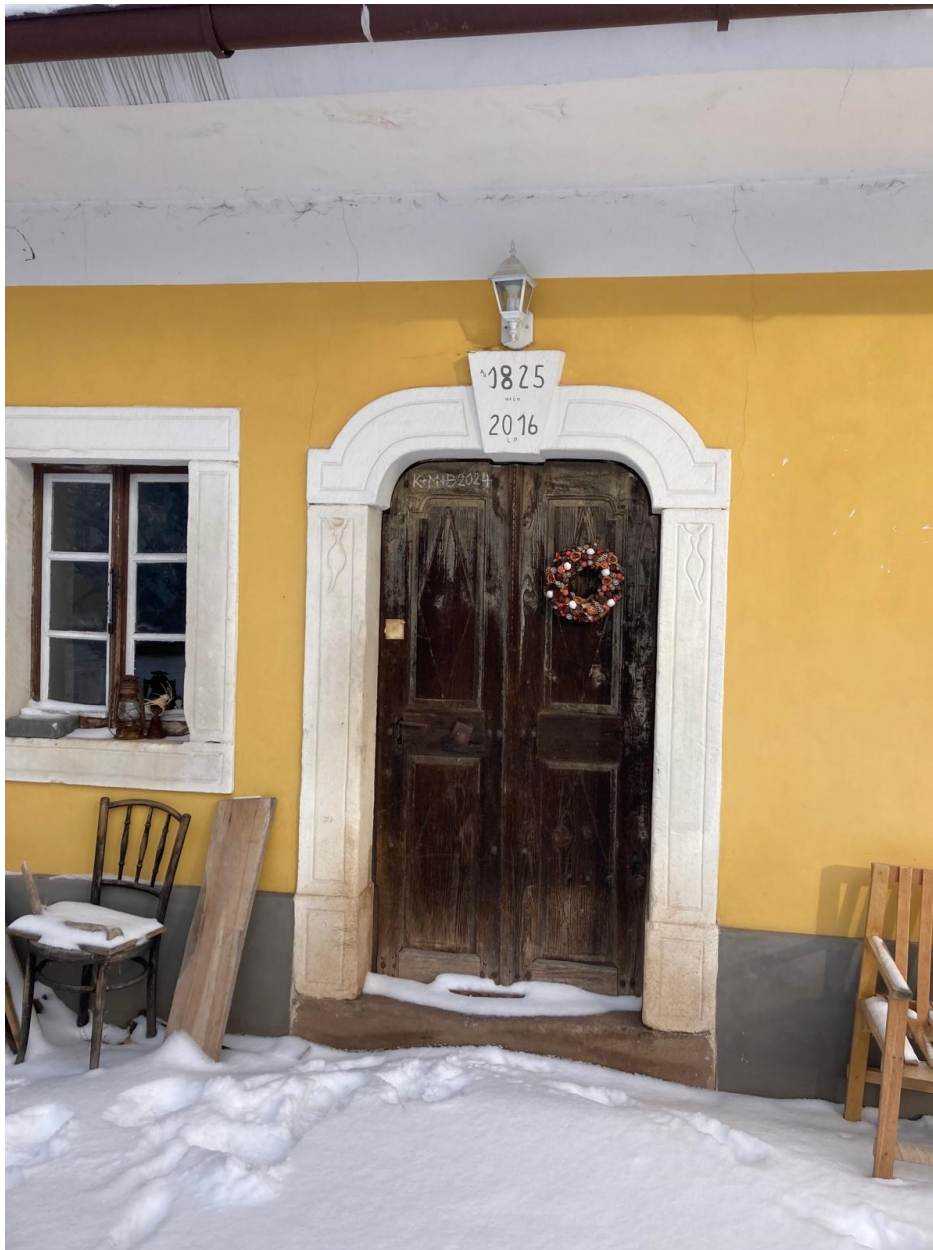
Příloha č. 7, pohled na vstup do obytné části statku, Křinice
