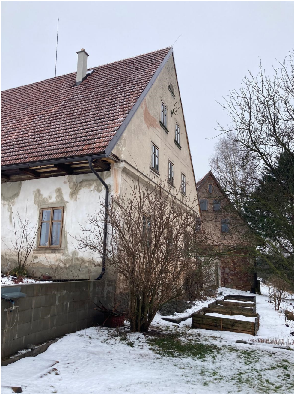
Příloha č. 12, Pohled na přední část prvního statku, Hejtmánkovice
