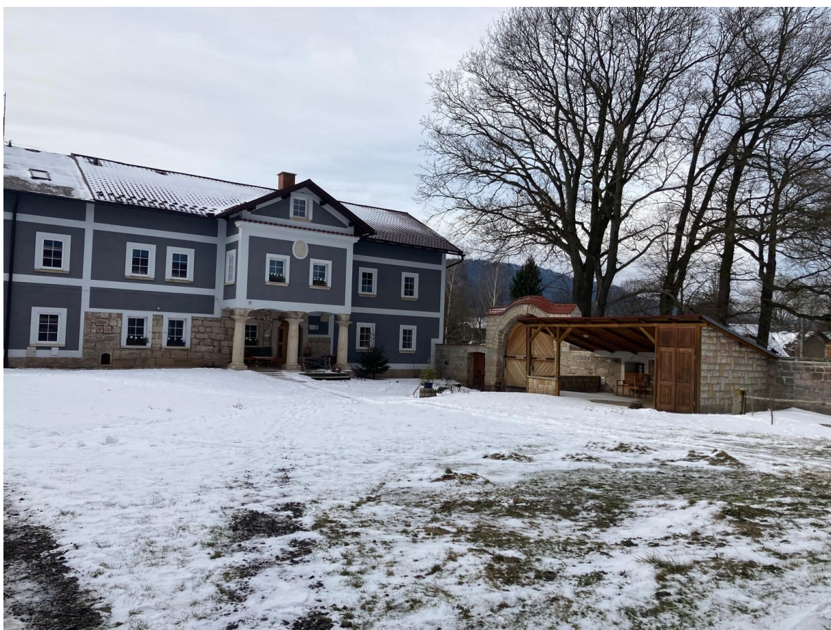
Příloha č. 8, Pohled na dvůr a obytnou část statku, Martínkovice
