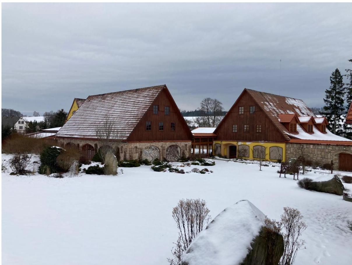
Příloha č. 22, Pohled na nádvoří druhého statku, Hejtmánkovice
