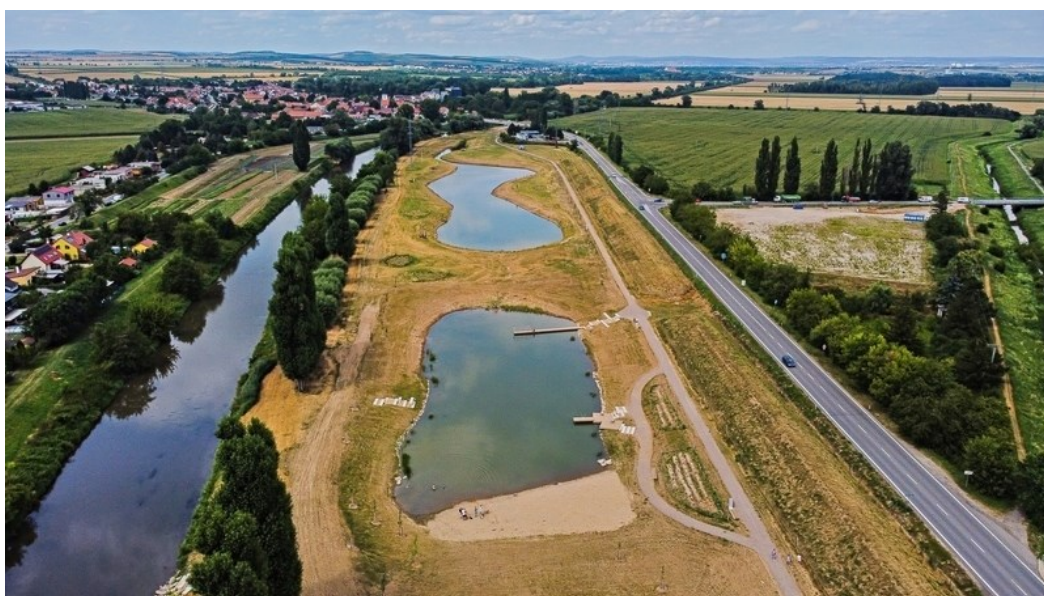
Obr. 29: Protipovodňový park Svratka nad Židlochovicemi na Brněnsku. Autor: CTK/Patrik Uhlíř (2024).
