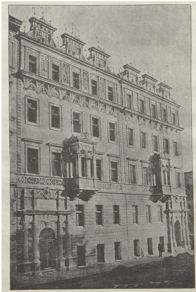
2. Domy č. p. 117/66 a 115/64 v dnešní Zborovské ul., Praha: Celkový pohled na fasády, dobová fotografie
