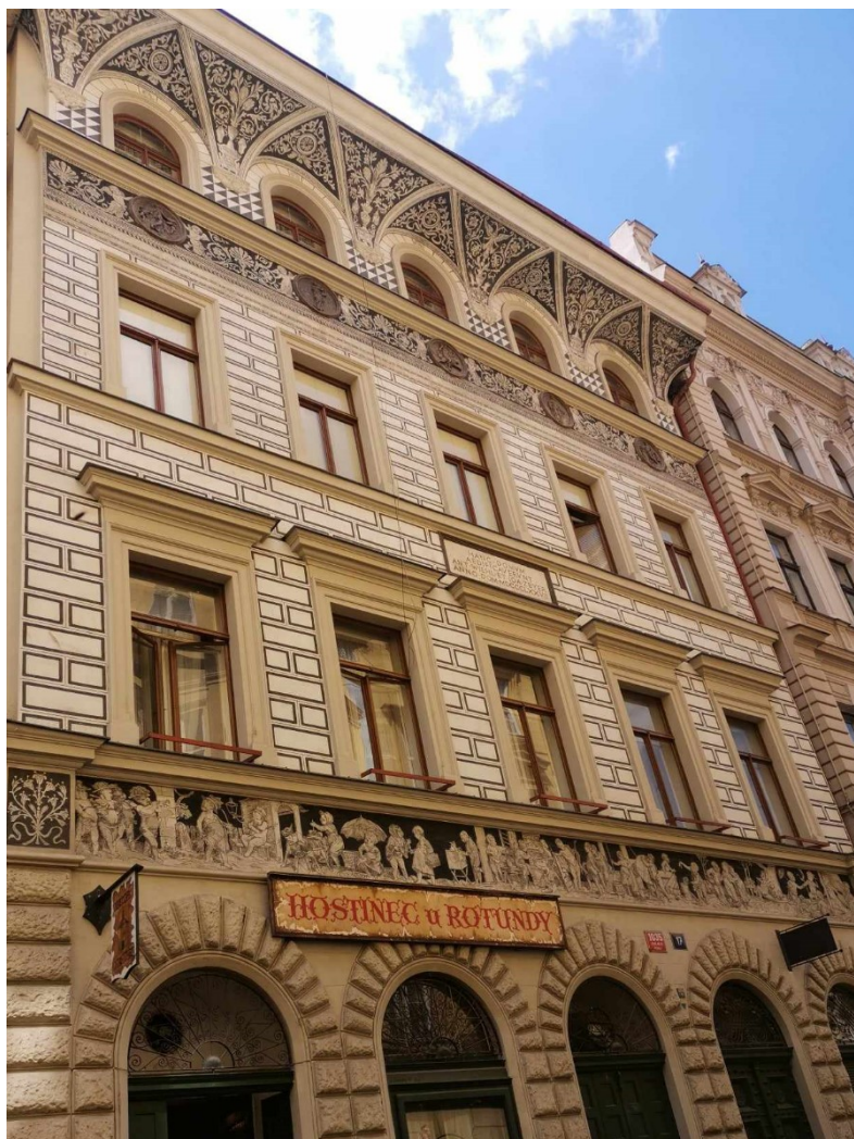
26. Dům v ul. Karoliny Světlé č. p. 1035/17, Praha: Celkový pohled na fasádu
