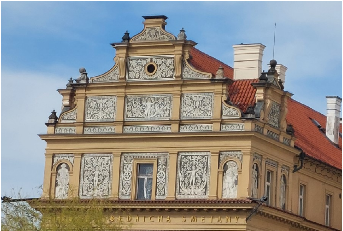
52. Staroměstská vodárna, Praha: Detail sgrafitové výzdoby jižní a východní fasády
