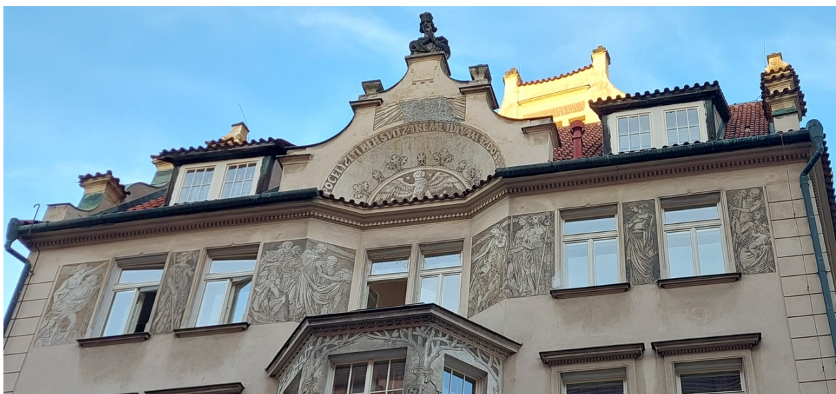
47. Hlávková studentská kolej, Praha: Detail sgrafitové výzdoby horní partie fasády směřující do Dittrichovy ulice
