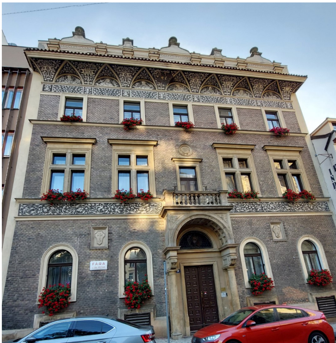
37. Fara u sv. Petra, Praha: Celkový pohled na fasádu
