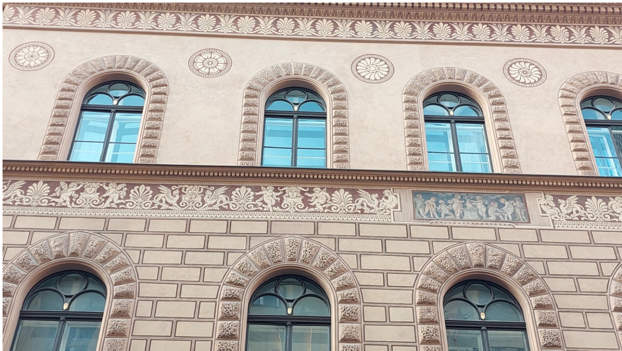
23. Schnirchův dům, Praha: Detail sgrafitových vlysů pod korunní římsou a pod okny druhého patra, rozety a kvádrování
