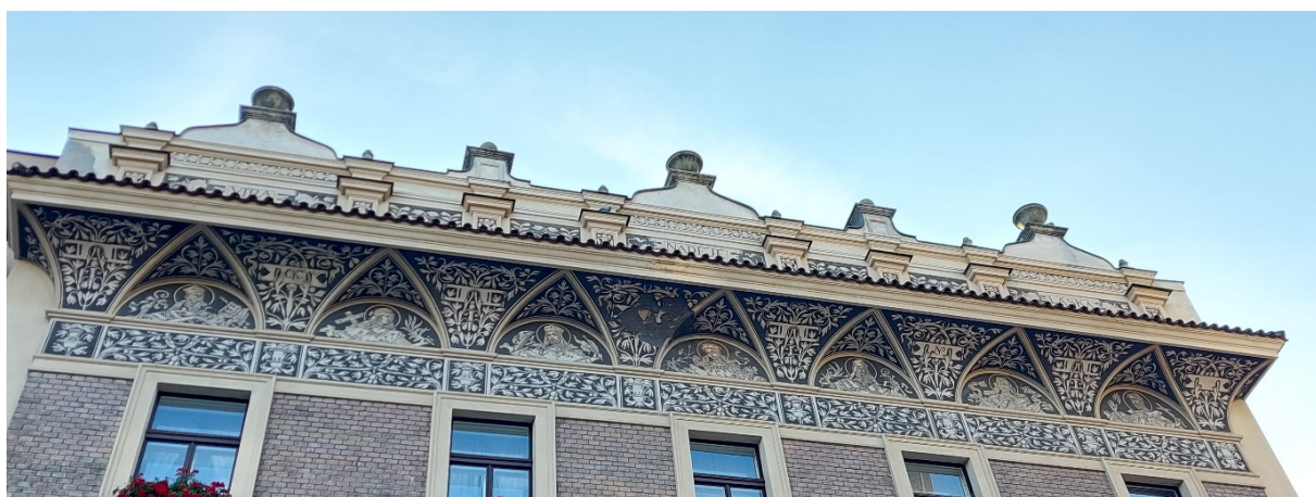
38. Fara u sv. Petra, Praha: Detail sgrafitové výzdoby na atice, lunetové římse a vlysu pod ní
