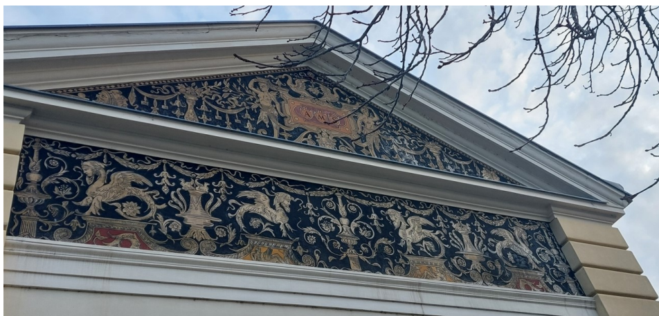
62. Pavilon pro výstavu uměleckou, Jubilejní zemská výstava 1891: Celkový pohled na sgrafitovou výzdobu pravé boční fasády – vlys a tympanon, současný stav
