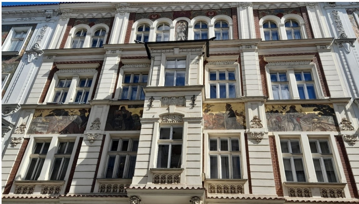
30. Dům č. p. 1046/6 v ul. Nerudova, Plzeň: Celkový pohled na fasádu
