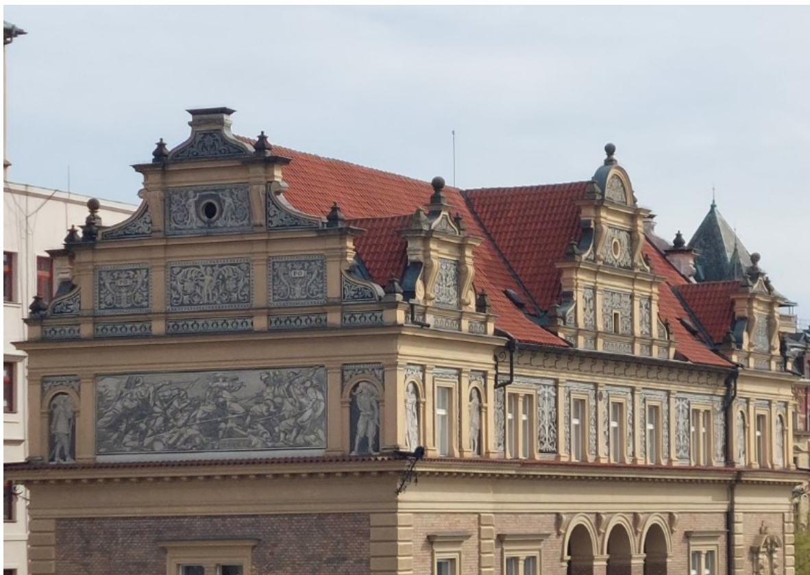
53. Staroměstská vodárna, Praha: Detail sgrafitové výzdoby severní a západní fasády
