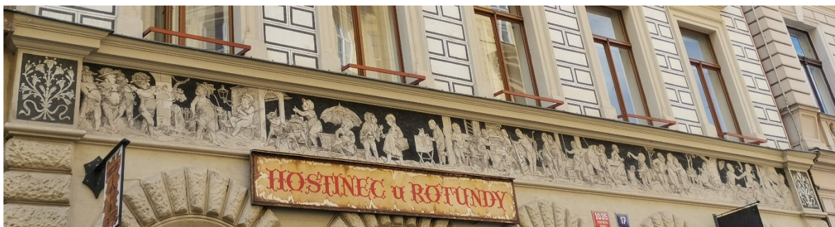
28. Dům v ul. Karoliny Světlé č. p. 1035/17, Praha: Detail sgrafitového vlysu pod okny prvního patra
