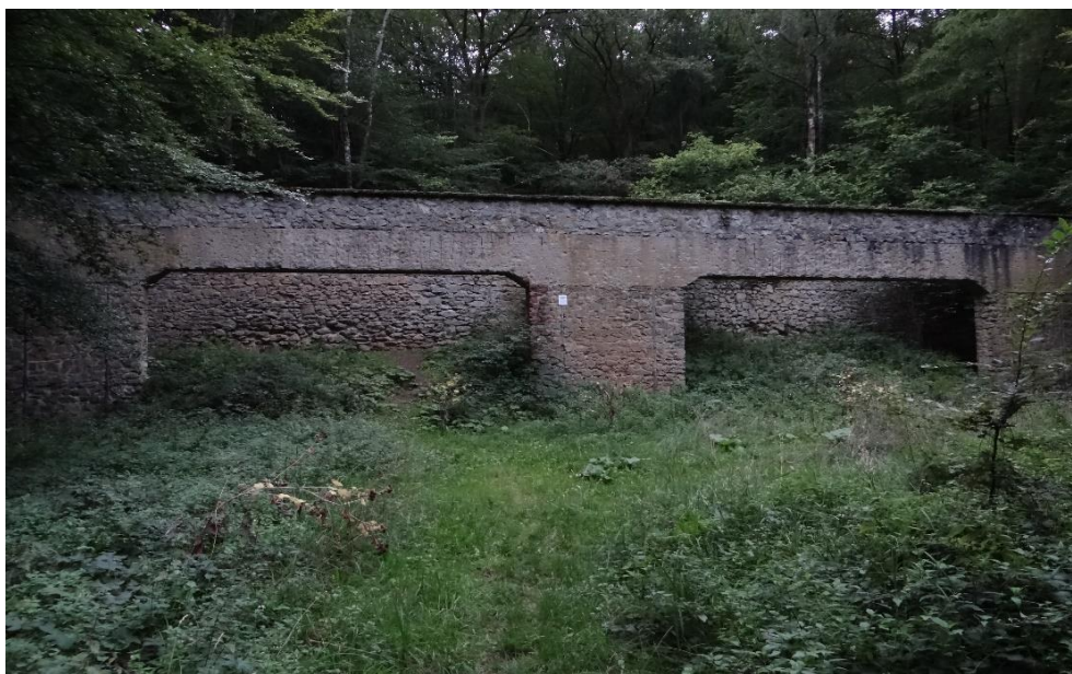
Obrázek 11 - Objekt pistolové střelnice stojící na úbočí kopce Medník (stav v roce 2019) – jedná se o stavbu o rozměrech přibližně 30x5 m, která je zhotovena převážně z kamene a betonu. Stavba je tvořena pouze dvěma stěnami, jež jsou mezi sebou spojeny třemi betonovými příčkami. Zatímco zadní stěna je zcela vyplněna kamením, v přední stěně se nachází dvě velká „okna“, která jsou zčásti vyplněna hliněným náspem. V jednotlivých oknech byly nejspíše rozmístěny střelecké terče, do kterých se měli vojáci střílet. Hliněný násep pak zřejmě sloužil k tomu, aby se do něj zavrtávaly vystřelené projektily a dále se neodrážely. Archiv autora
