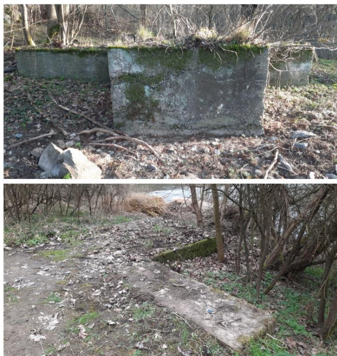
Obrázek 49 - Dochované betonové základy pěší lávky přes řeku Sázavu. Pilíř zachycený na horním obrázku se nachází na levém břehu Sázavy, pilíř na spodním obrázku zase na pravém. Konstrukce samotné lávky byla pravděpodobně dřevěná a k těmto betonovým patkám byla přichycena mohutnými železnými šrouby, které jsou zde dodnes k vidění. Archiv autora
