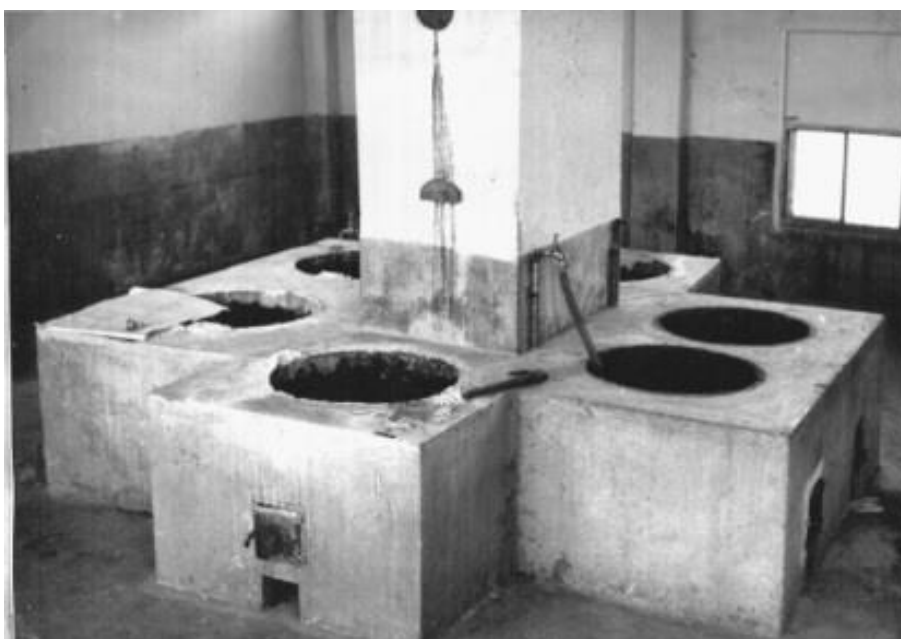
Obrázek 35 - Tělocvična obecné a měšťanské školy v Benešově byla přestavěna na kuchyň. Státní oblastní archiv v Praze
