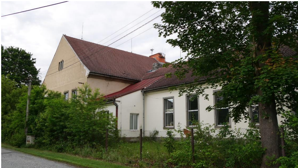
Obrázek 13 - Dnešní podoba velké společenské budovy do tvaru písmene T, která stojí jen necelých 100 metrů od areálu hradištského zámku (někdejšího sídla velitelství ženijní školy). Co se půdorysu týče, zůstala budova od dob války víceméně stejná, pouze dvě krátká postranní křídla vycházející kolmo od čela hlavní budovy nesou viditelné známky nedávné rekonstrukce. Archiv autora
