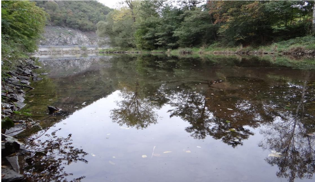
Obrázek 12 - Umělé rameno vyhloubené do pravého břehu řeky Vltavy. Během války sloužilo jakožto kotviště různých druhů člunů. Stavba má třístěnného obdélníku o rozměrech cca 90x25 m a je vybudována z kamenů a hliněných násypů. Po obvodu obou delších stěn se nachází několik řad širokých dlážděných schodišť vedoucích k hladině. V kratší stěně byl zase vybudován pozvolný nájezd, který zřejmě sloužil k vytahování lodí (či jiné techniky a materiálu) na souš, nebo naopak k jejich spouštění na hladinu. Archiv autora
