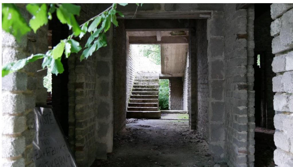
Obrázek 15 – Pohled vstupními dveřmi do interiéru nedokončené budovy pošty. Archiv autora
