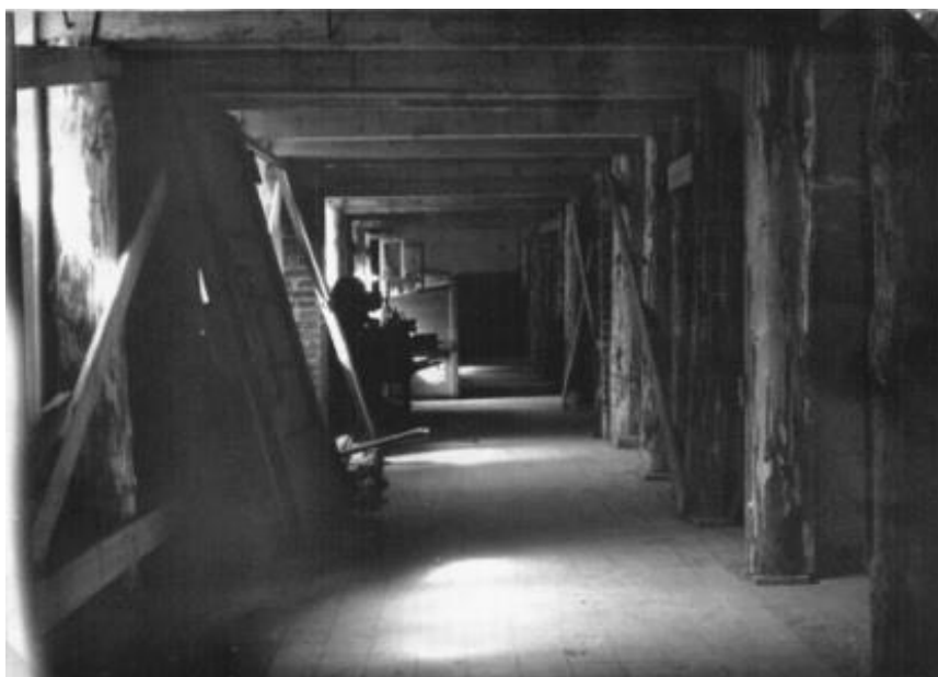
Obrázek 36 - Strop suterénu měšťanské školy byl vyztužen silnými dřevěnými trámy - tento prostor měl pak v případě náletů zřejmě sloužit jako protiletický kryt. Státní oblastní archiv v Praze
