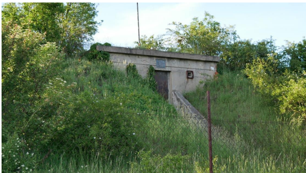
Obrázek 16 – Zemní vodojem v lokalitě „Nade vsí“, který nechala správa výcvikového prostoru vybudovat v roce 1943. Archiv autora
