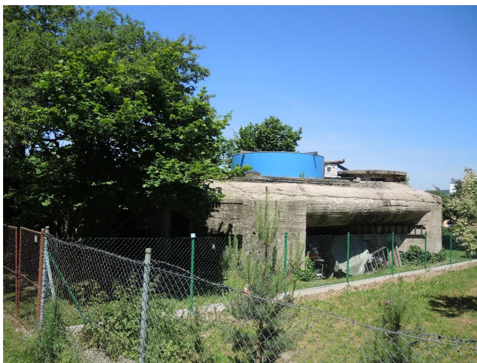
Obrázek 19 - Poslední dochovaný betonový bunkr v lokalitě "na Sekance". Tento objekt je na první pohled velmi odlišný od všech ostatních staveb podobného charakteru, se kterými se dodnes můžeme na území výcvikového prostoru setkat. Svým tvarem a půdorysem bunkr nápadně připomíná některé těžší typy československých pohraničních pevností vybudovaných v meziválečné době. S velkou pravděpodobností se mělo jednat o jakousi přibližnou repliku některé z těchto pevností, na které pak byly v rámci výcviku zjišťovány její slabiny a odolnost. Archiv prof. V. Matouška
