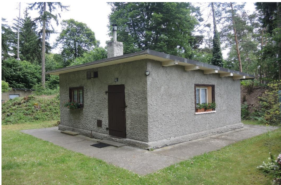
Obrázek 20 - Nedávná podoba jednoho ze soustavy menších betonových skladišť munice, která se nacházela na severním okraji Hradištká. V poválečných letech byl tento objekt majiteli pozemku přestavěn na obytnou chatku. Archiv prof. V. Matouška
