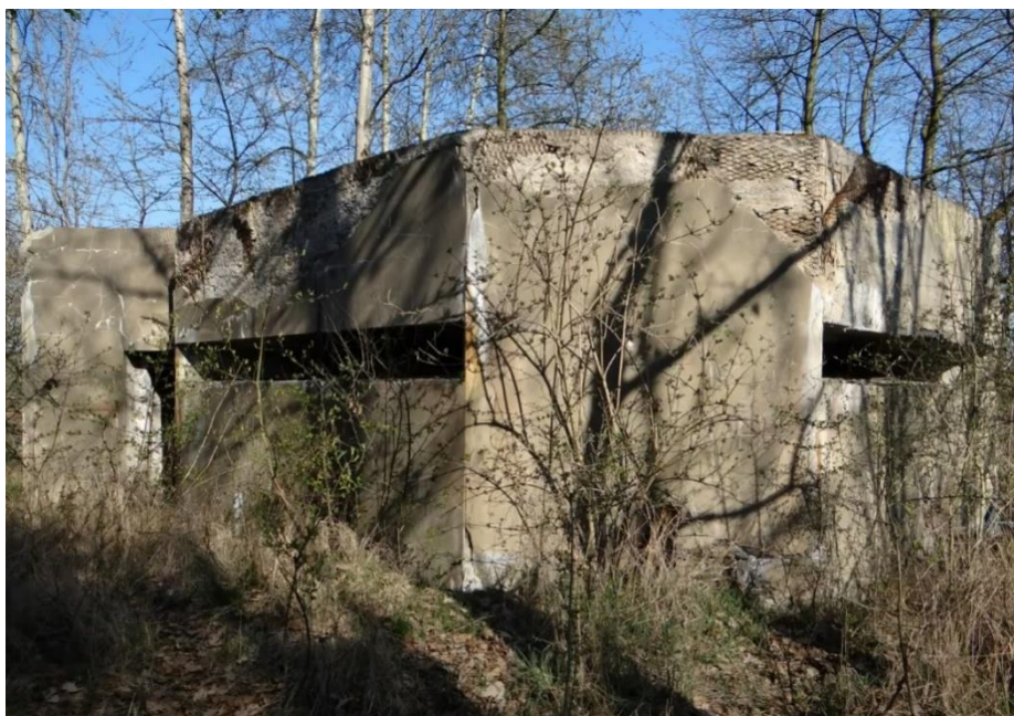
Obrázek 40 - Pravděpodobně nejzajímavějším dokončeným objektem v prostoru obou střeleckých pásem je tato dvoustranná velitelská pozorovatelná, která se nachází nad Horním úročnickým rybníkem. Vchod pro pěší se nachází v postranní části budovy. Odtud pak vede dlouhá chodba, která o několik metrů dále navazuje na dvě oddělené pozorovací místnosti, jejichž průzory se nachází ve dvou proti sobě ležících skosených stěnách objektu. Tato konfigurace poskytovala vojákům velmi dobrý výhled severozápadním, západním a jihozápadním směrem. Týlová část objektu dosahuje délky cca 12,5 m, boční stěny zhruba 4 m a délka dvou skosených čelních stěn se pohybuje okolo 5 m. Vnější stěny objektu pak mají sílu zhruba 1,5 m. 108 Archiv autora
