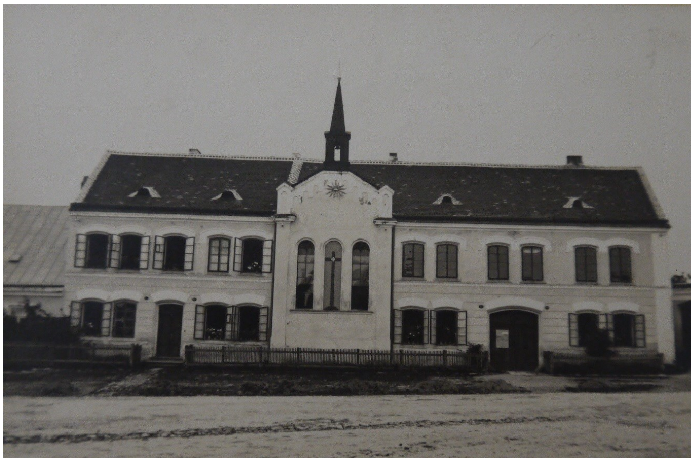
Fotografie průčelí Rudolfína po opravě a barevném sjednocení fasády.
