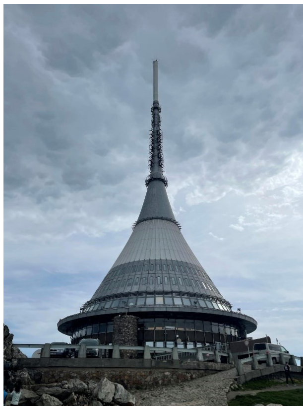
23. Liberec , hotel a vysílač Ještěd, celkový pohled na Ještěd, 5. května 2024, foto: Karolína Palčeková
