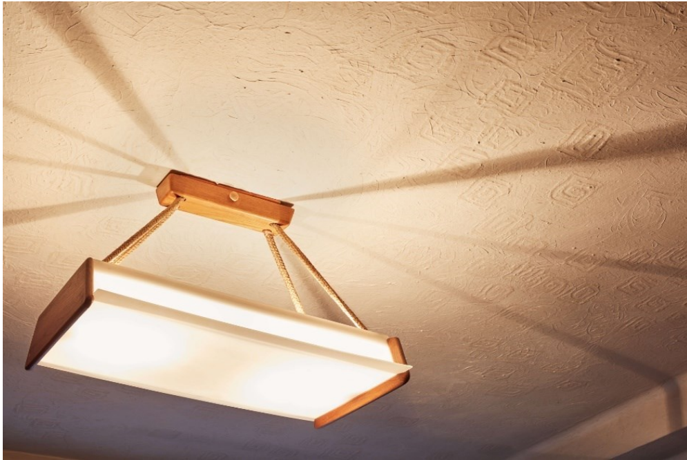
65. Liberec , montovaný dům Karla Hubáčka, detail stropu s plastickou malbou, kterou vytvořil Karel Hubáček, barva nanášená prstem, 2023, foto: Radek Úlehla
