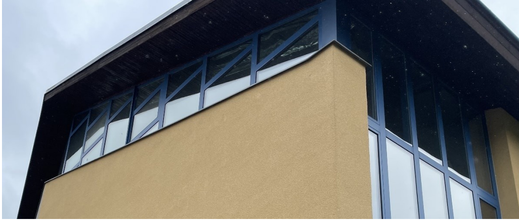
9. Doksy , kino Máj, detail sedlové střechy s dřevěným deštěním, 18. května 2024, foto: Karolína Palčeková
