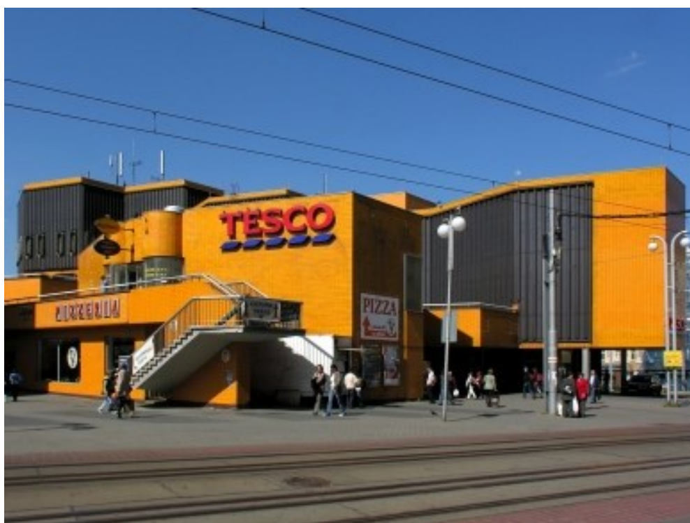
46. Liberec , obchodní středisko Ještěd, venkovní schodiště, 3. května 2007, foto: Lukáš Beran
