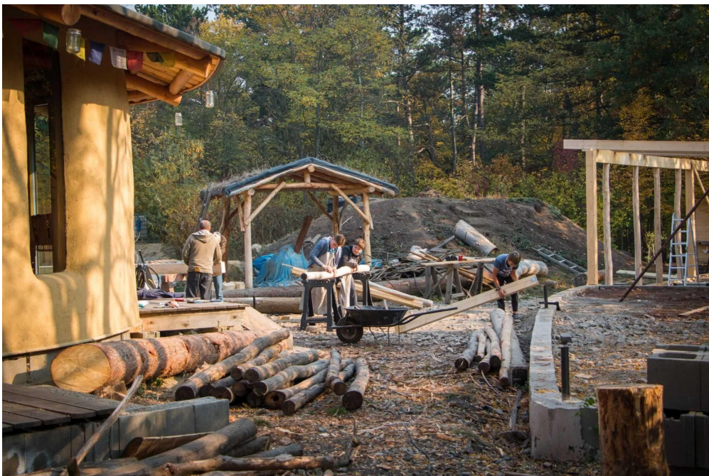
Základní škola Na Beránku – Zahrada (foto archiv školy)
