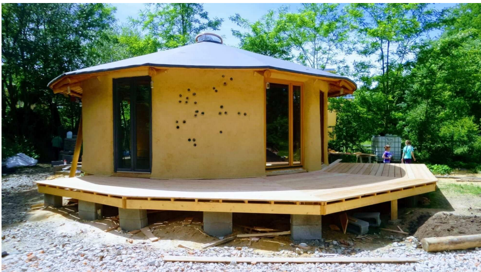
Základní škola Na Beránku – Zahrada (foto archiv školy)
