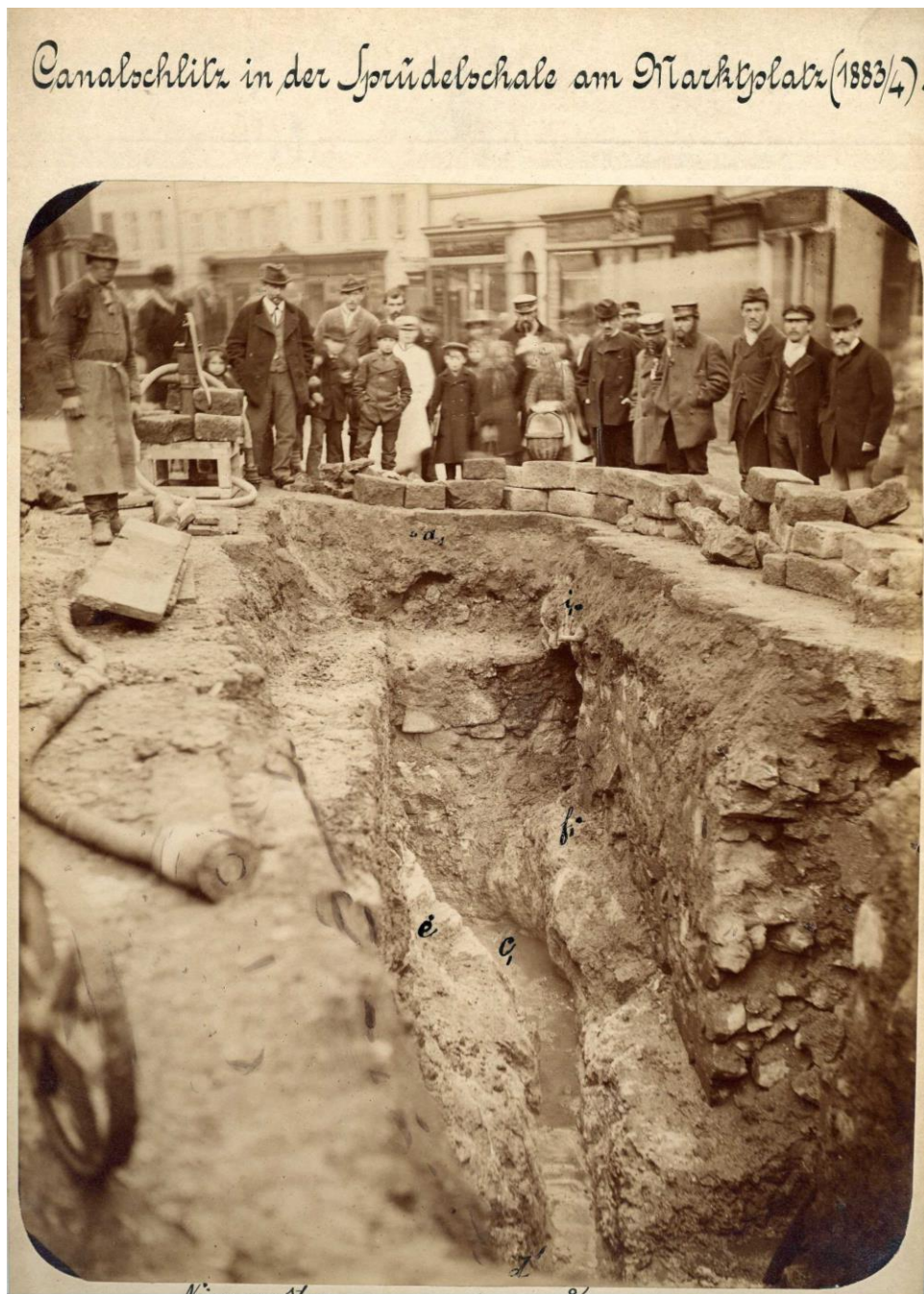
Obr. 24 Starší dokumentace výkopů na Tržišti (1884)
