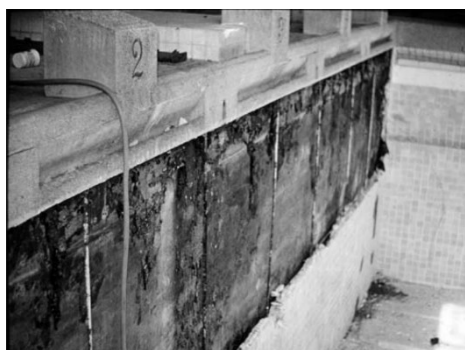
Obr. Dutina za stěnou bazénu
