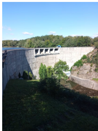
Foto 28: Pohled na hráz vodní nádrže Vrchlice (vlastní foto)
