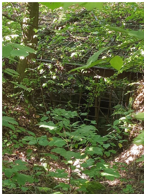
Foto 27: Jeden ze vstupů do dolu zakrytý mříží (vlastní foto)
