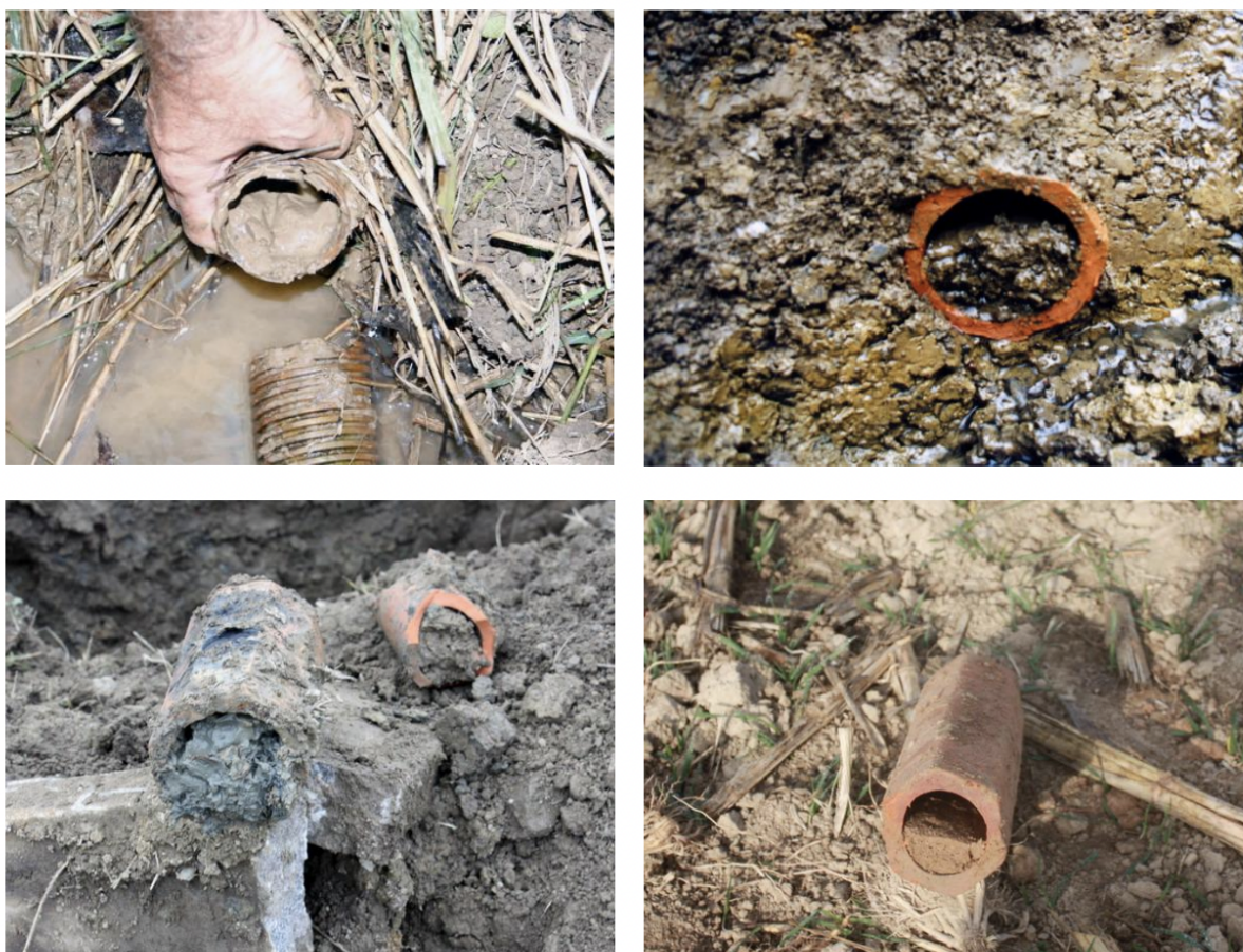
Obrázek 4 Příklady částečného nebo úplného zanesení drenů zemitými částicemi. U částečného zanesení drenážní prvek nadále plní odvodňovací a transportní funkci v závislosti na rozsahu zmenšení světlosti drenážního potrubí. Jiné důsledky zanesení jsou u drenů sběr
