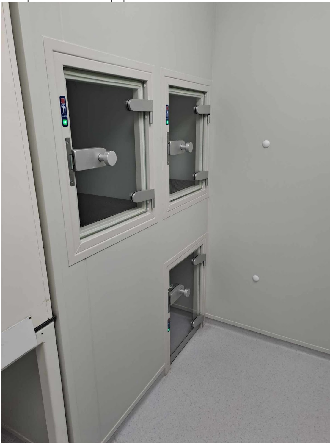
Přestupní okna materiálové propusti
