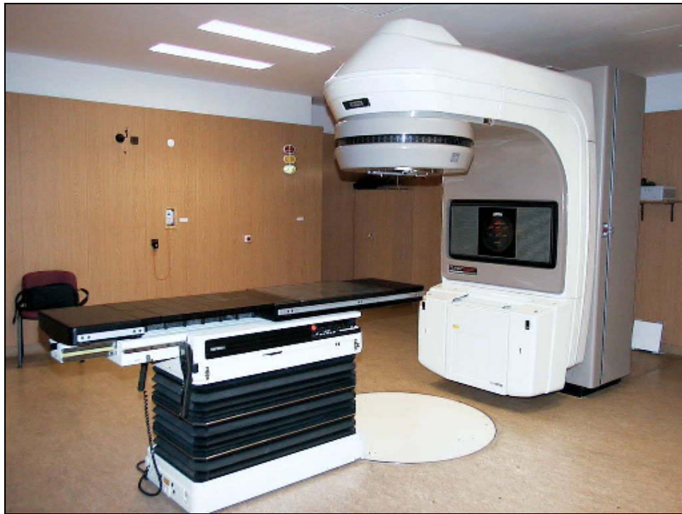
Obr.č.13 Lineární urychlovač s energií fotonů 6 MeV (Varian 600C). (16)
