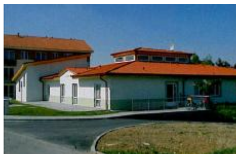
Obr. 14. Novostavba Domova Simeon pro poskytování úlevové (respitní) péče.
