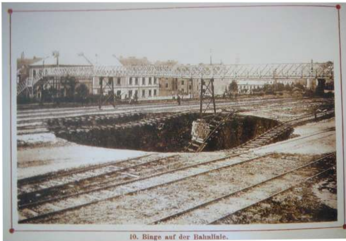
Obr.13 Pohlednice průvalu kuřavky na nádraží v Mostě
