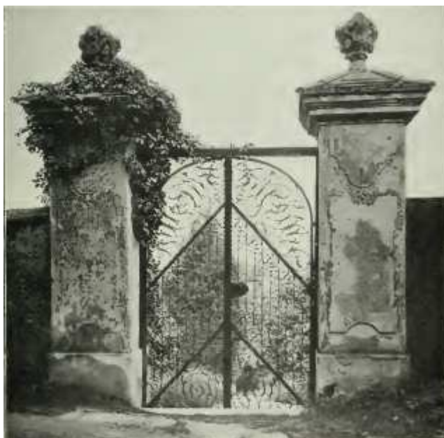
Obr. 1: Renesanční kovaná brána (dnes zrekonstruovaná) v parkové zdi lojovického zámku, odkud dříve vedla cesta do lesa Velešinka. Zděné pilíře se zachovaly, ovšem bez kamenných barokních váz.
