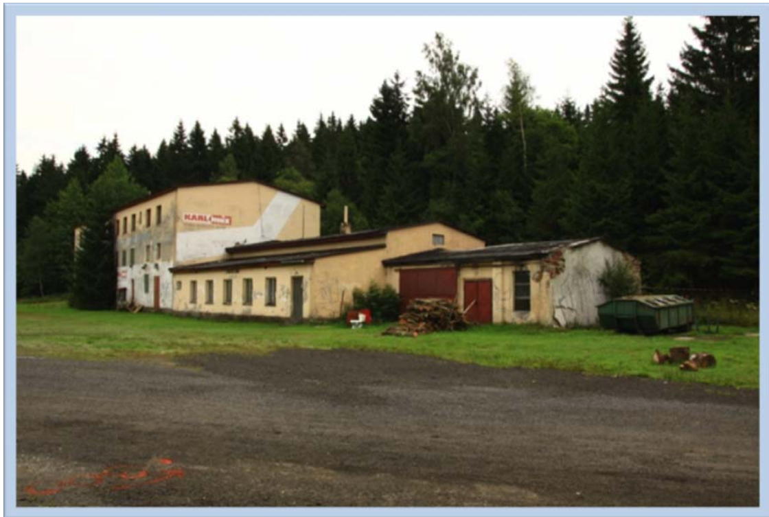
Obrázek č. 17 – Hlavní budova s bufetem a garáží
