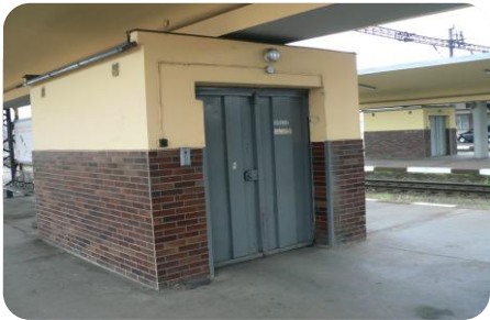
nákladní výtah pro vozíčkáře na vlakovém nádraží
