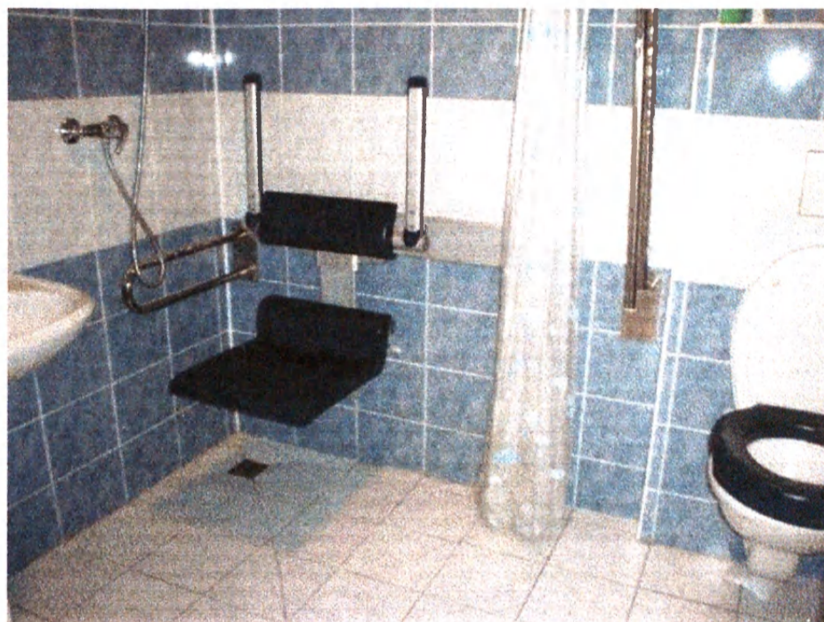
Obr. 3: Bezbariérová kúpeľňa Centra Paraple
