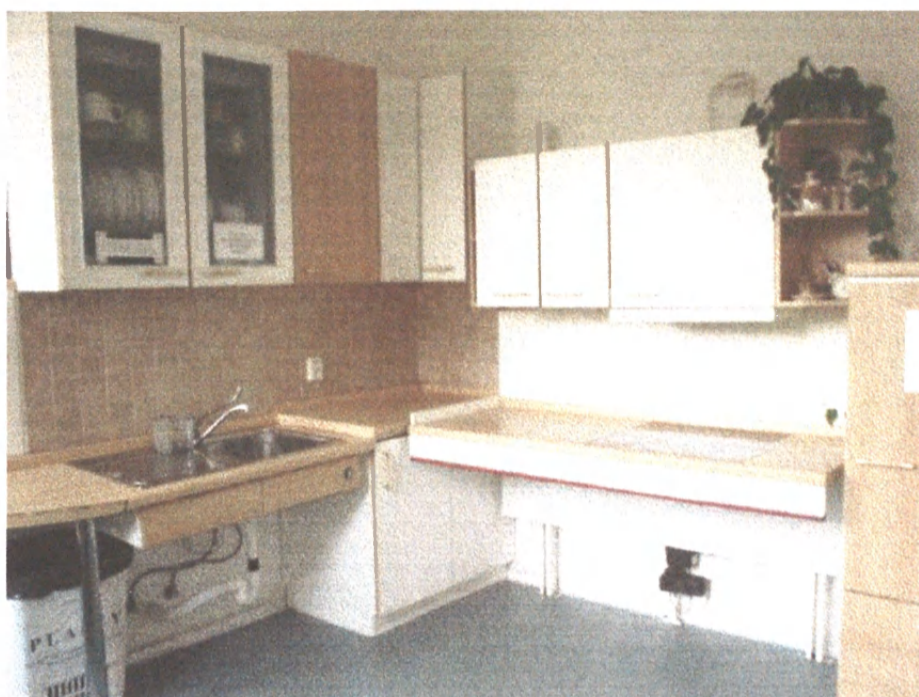
Obr. 5: Bezbariérová kuchyň značky Koryna v Centru Paraple: V pravé části kuchyňské linky je elektricky nastavitelná výška pracovní desky a výška závěsných skříněk. V levé části linky je elektricky nastavitelná výška pracovní desky se dřezem a výška vnitřní části skřínky s koši na nádobí. Ovládací prvky jsou umístěny na přední straně pracovních desek.
