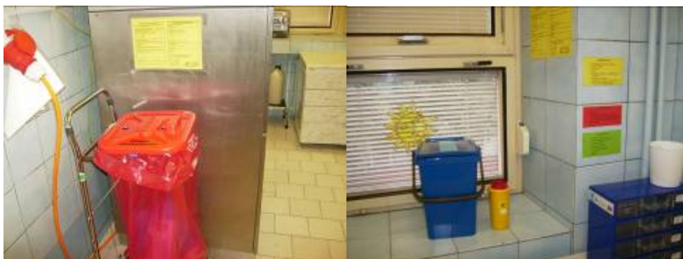
Obrázek č. 5 Vybavení dekontaminační místnosti operačního sálu shromažďovacími prostředky
