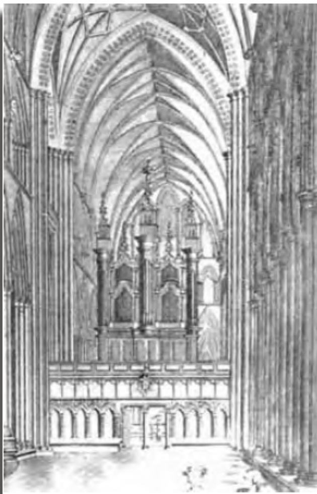
3. Salisburská katedrála, pohled na hlavní loď z východu, před restaurováním J. Wyatta
