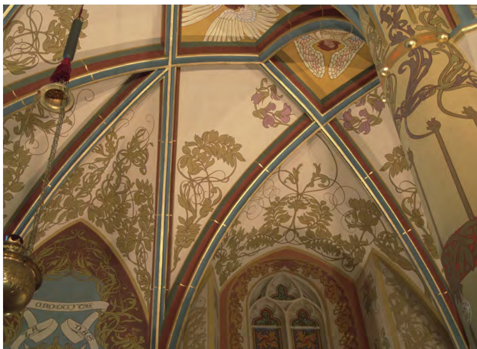
40. Kaple ve Vlašském dvoře, pohled do klenebních polí stropu kaple, současný stav
