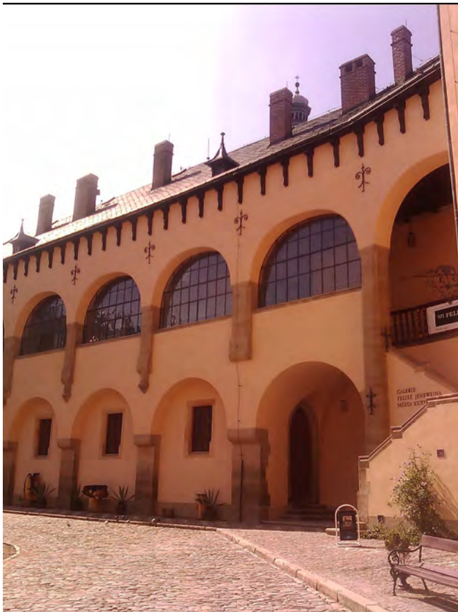
23. Vlašský dvůr, současný stav, detail patra západního křídla
