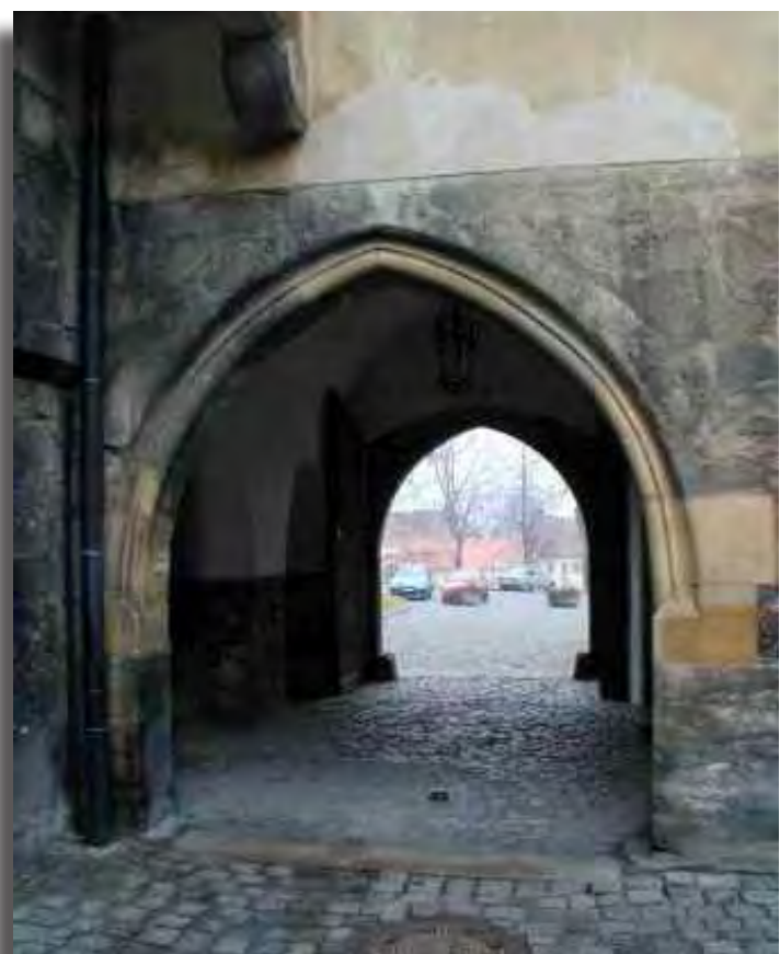
28. průjezd vstupní brány, nově vytvořený, současný stav
