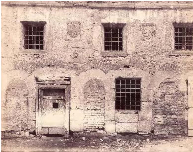
17. Vlašský dvůr, průčelí šmiten jihovýchodního křídla, stav po sejmutí fasády Kolem r. 1890, J. Steffel, České muzeum stříbra v Kutné hoře
