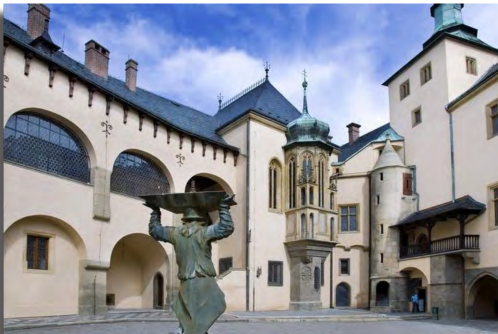
25. Vlašský dvůr, současný stav pohled na část západního křídla a severní část s kaplí
