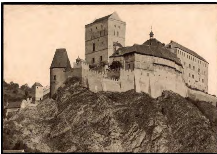
65. Karlštejn, stav před přestavbou, rok 1875
