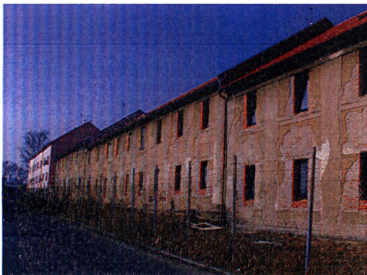
Objekt č.p. 156 – před rekonstrukcí
