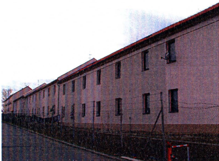
Objekt č.p. 156 – po rekonstrukci
