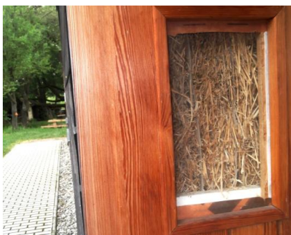
Průřez stěnou pasivního domu.
