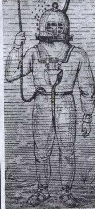
1829 V Kronštatě navrhl Gauzen přilbu s oddělitelným náptecníkem
