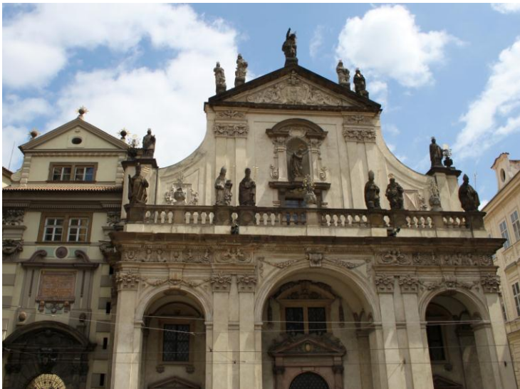
Kostel Nejsvětějšího Salvátora - průčelí
