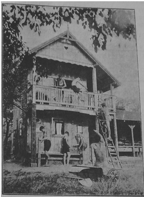
Výstavba hlavní budovy Dětské farmy
