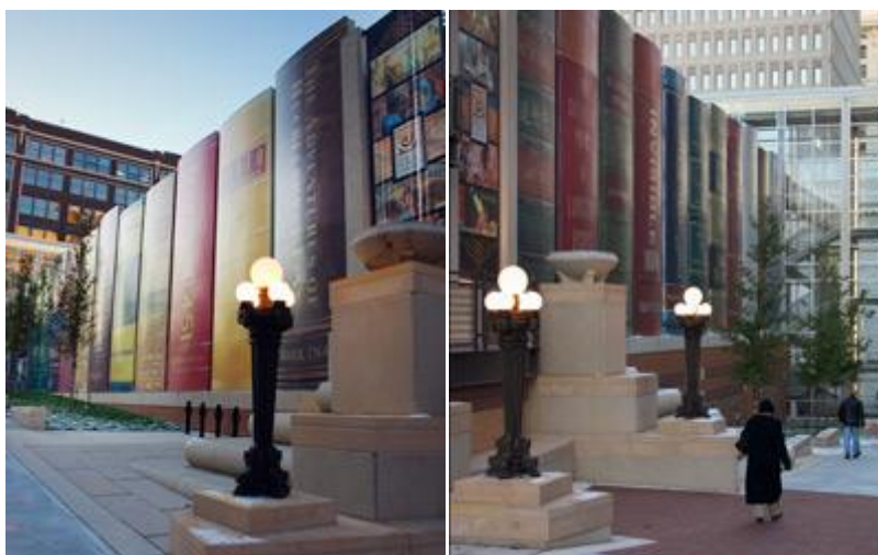
Obrázek č. 10 - Fasáda budovy garáží Veřejné knihovny města Kansas (USA), [The Kansas, 2013]
