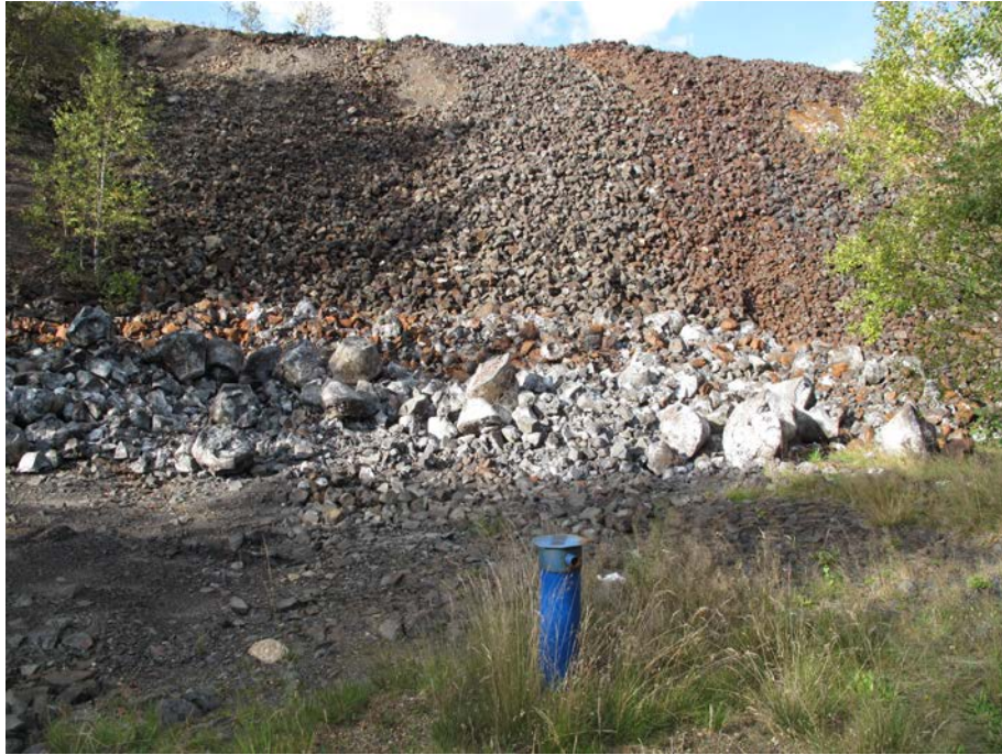
Obr. 19. Monitorovací vrt HV 303 pod haldou strusky č. 2 (foto: O. Šebek).
