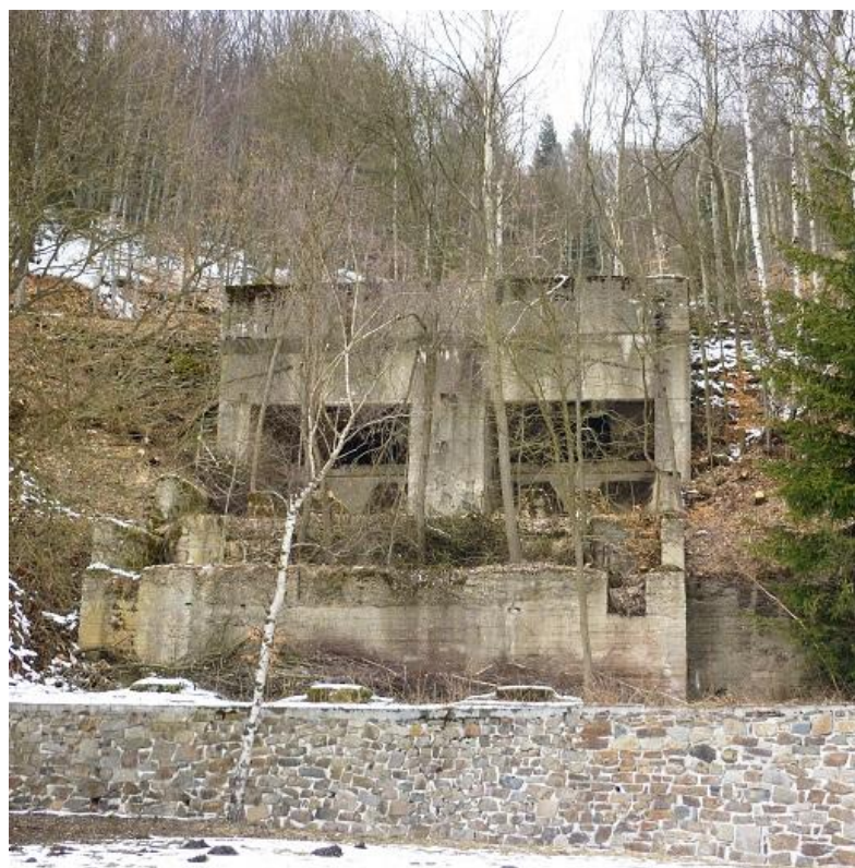
Obr. 11: Pozůstatek objektu drtičky u Křimovské přehrady
