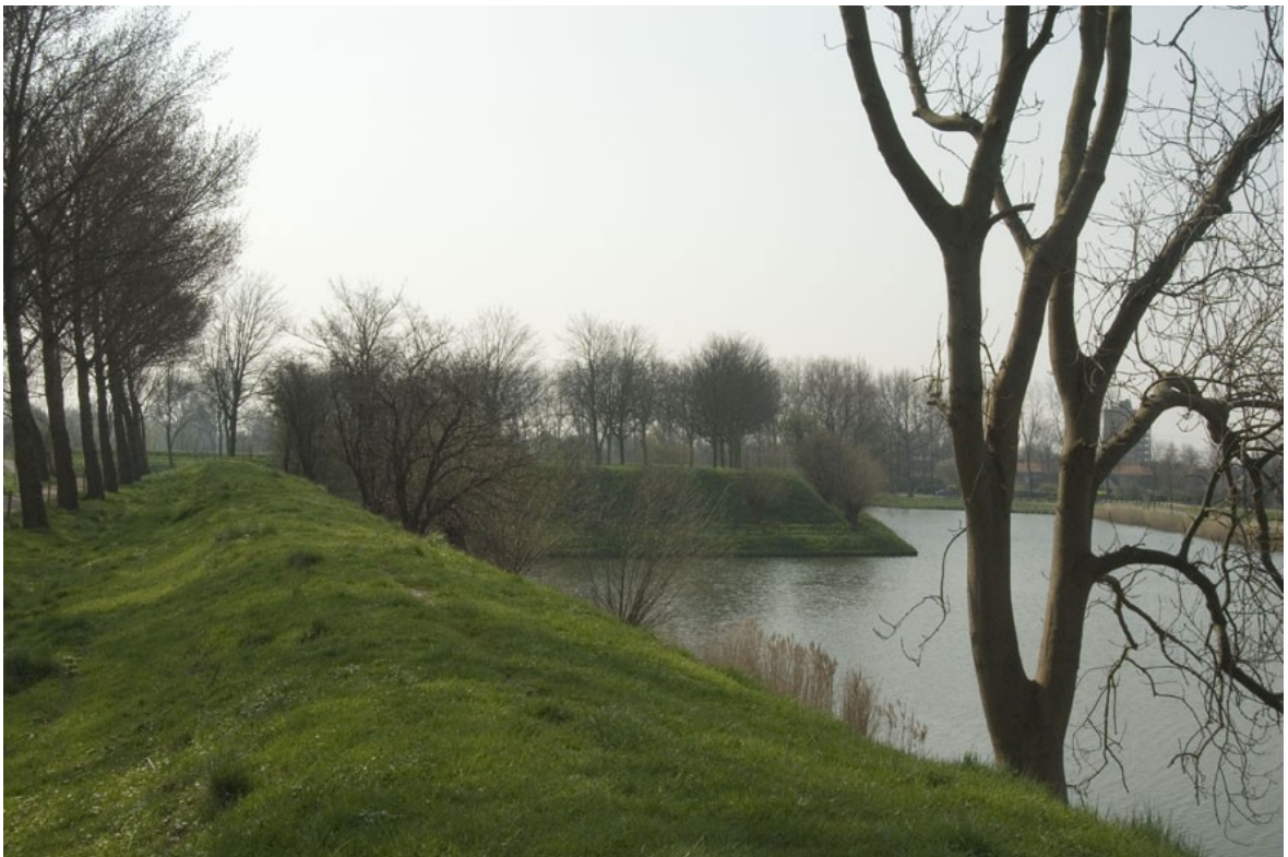
Pevnost Brille, postavená podle čistě staroholandské školy. Zde ve větším detailu čistě zemní provedení valů a široké vodní příkopy, typické pro holandskou fortifikační školu.
