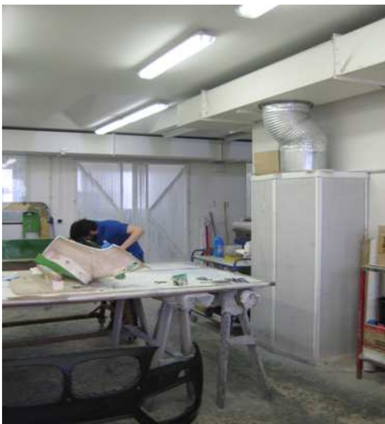
Obrázek 8 – přísun rekuperovaného a čerstvého vzduchu do dílny opravy forem
