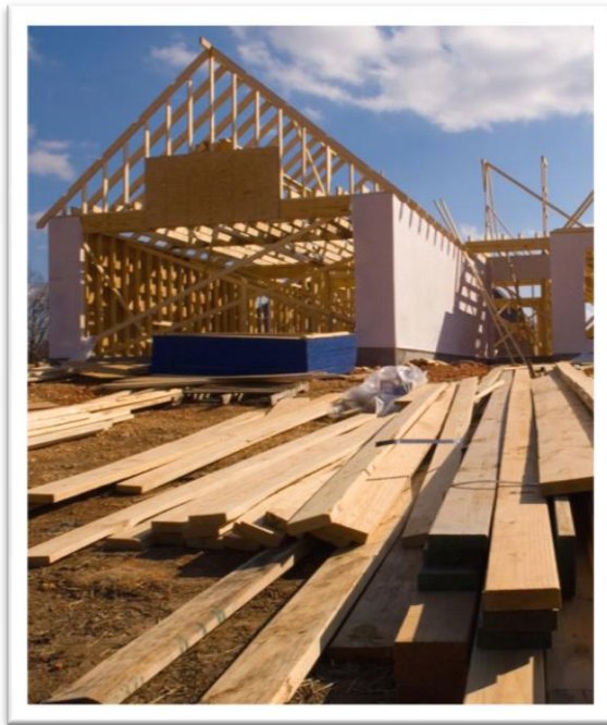
Obr. 2 Stavba pomocí two-by-four systému (Zdroj: České stavby, cit. 9. 8. 2012)
