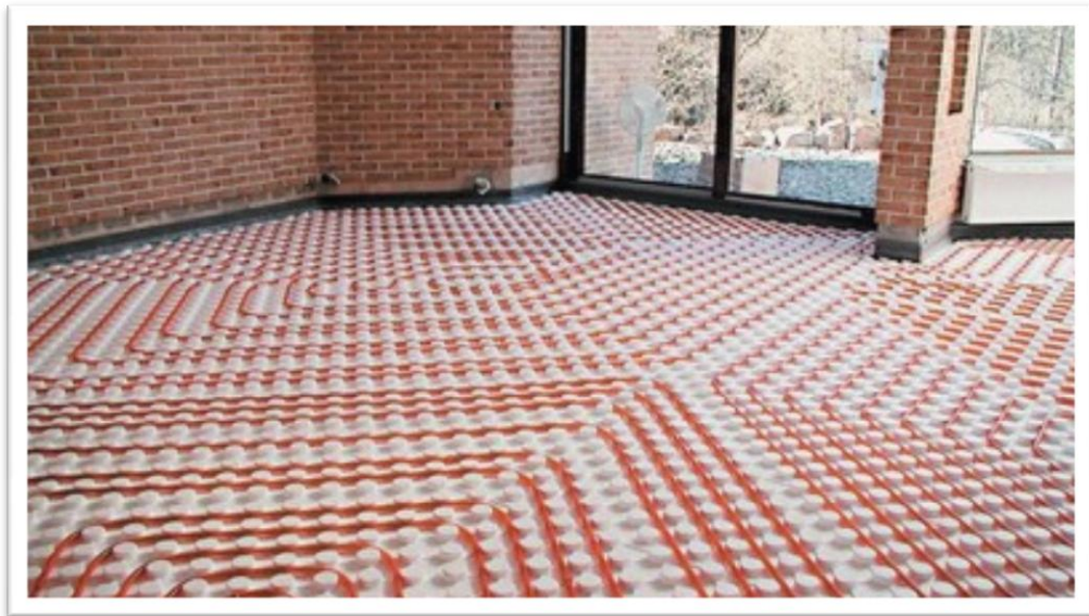
Obr. 10 Teplovodní podlahové vytápění (Zdroj: Podlahové topení, cit. 9. 8. 2012)
