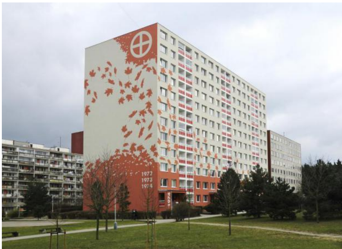
Obr. 1: vítěz v anketě o nejpěkněji revitalizovaný panelový dům na Jižním Městě 2011
