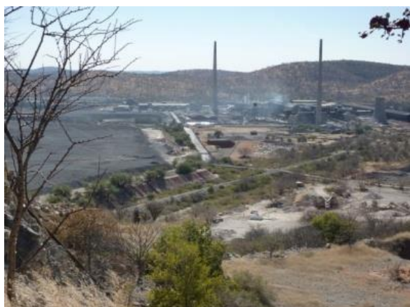
Obr. 7. Huť s odkališti flotačních odpadů překrytými struskou (vlevo) a skládka strusky (vpravo) na lokalitě Tsumeb. Foto V. Ettler.
