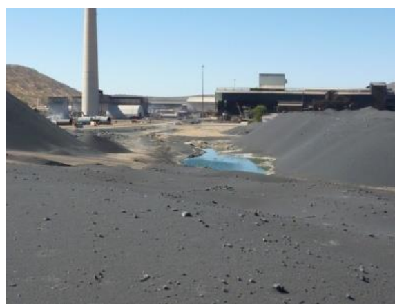
Obr. 7. Huť s odkališti flotačních odpadů překrytými struskou (vlevo) a skládka strusky (vpravo) na lokalitě Tsumeb. Foto V. Ettler.
