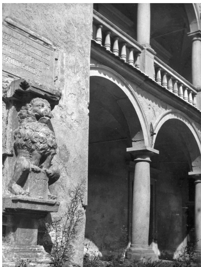
22. Brtnice, zámek, detail kamenné výzdoby, kol 1593
