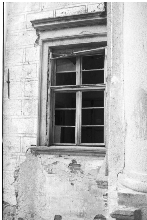
25. Brtnice, zámek, okno severního palác
