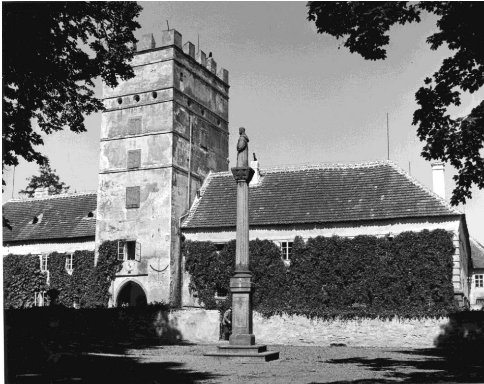
12. Brtnice, zámek, vstupní brána s věží, pohled z jihu
