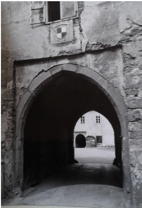
13. Brtnice, zámek, vstupní brána, pohled z jihu
