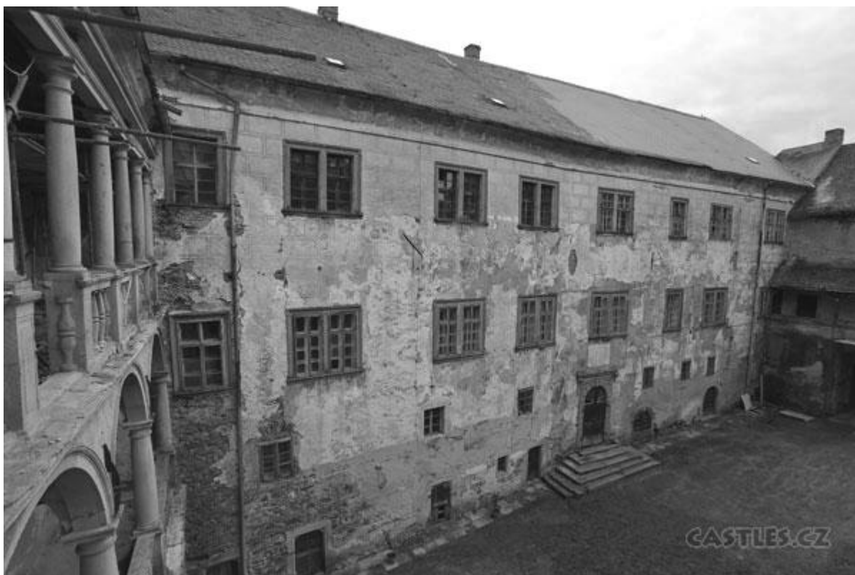
34. Brtnice, zámek, východní křídlo hlavního nádvoří, pohled ze severozápadu
