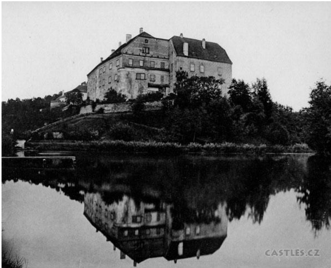
10. Brtnice, zámek, pohled ze severu na východní a severní křídlo třetího nádvoří
