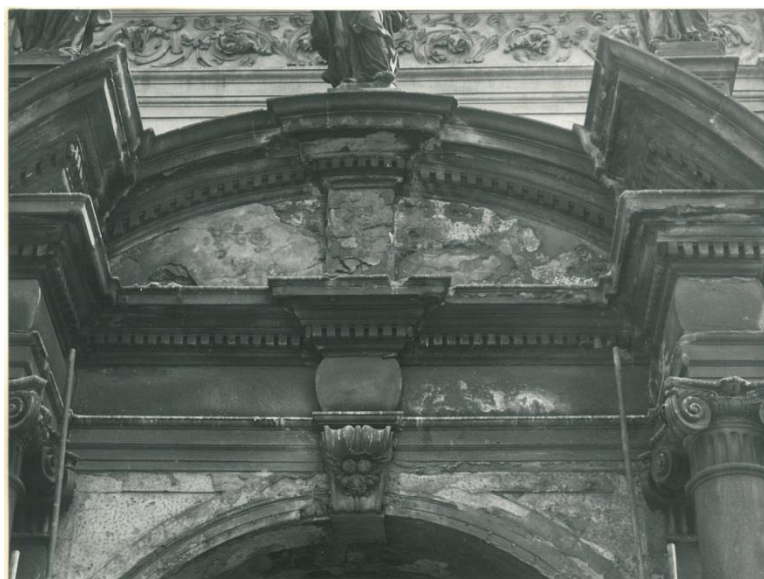
Obrázek 36: Stav kostela před rekonstrukcí v sedmdesátých letech minulého století; archiv kostela sv. Ignáce, složka K47
