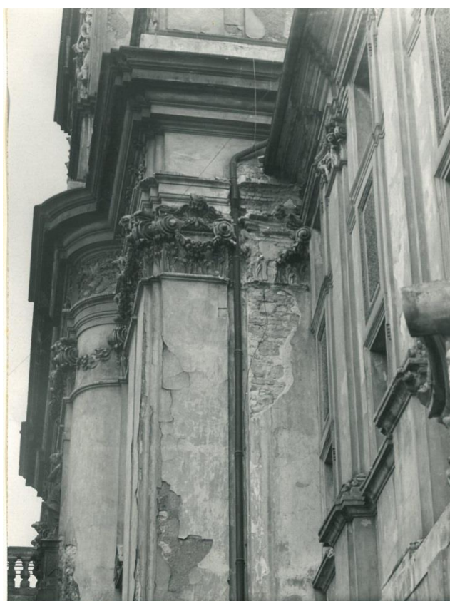
Obrázek 37: Stav kostela před rekonstrukcí v sedmdesátých letech minulého století; archiv kostela sv. Ignáce, složka K47
