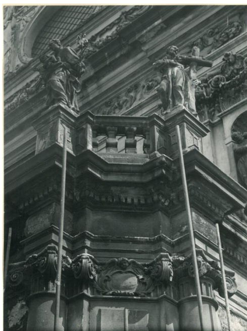
Obrázek 35: Stav kostela před rekonstrukcí v sedmdesátých letech minulého století; archiv kostela sv. Ignáce, složka K47
