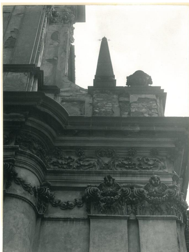
Obrázek 38: Stav kostela před rekonstrukcí v sedmdesátých letech minulého století; archiv kostela sv. Ignáce, složka K47
