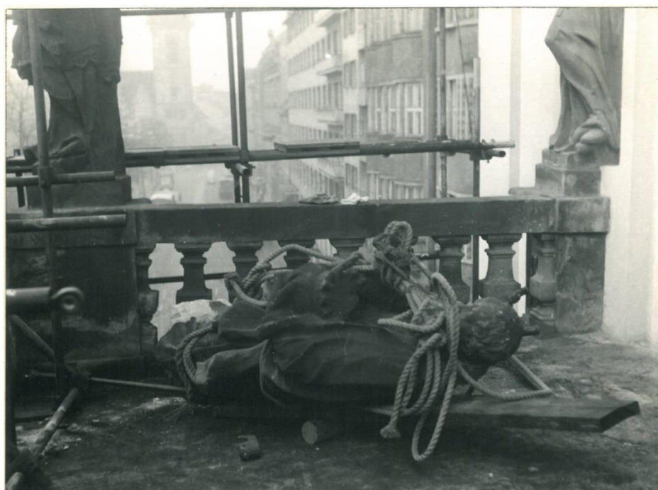
Obrázek 39: Rekonstrukce portiku a výroba dvou kopií jezuitských světců v roce 1972; archiv kostela sv. Ignáce, složka K83
