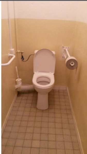
WC – Interna, Obrázek č. 39
