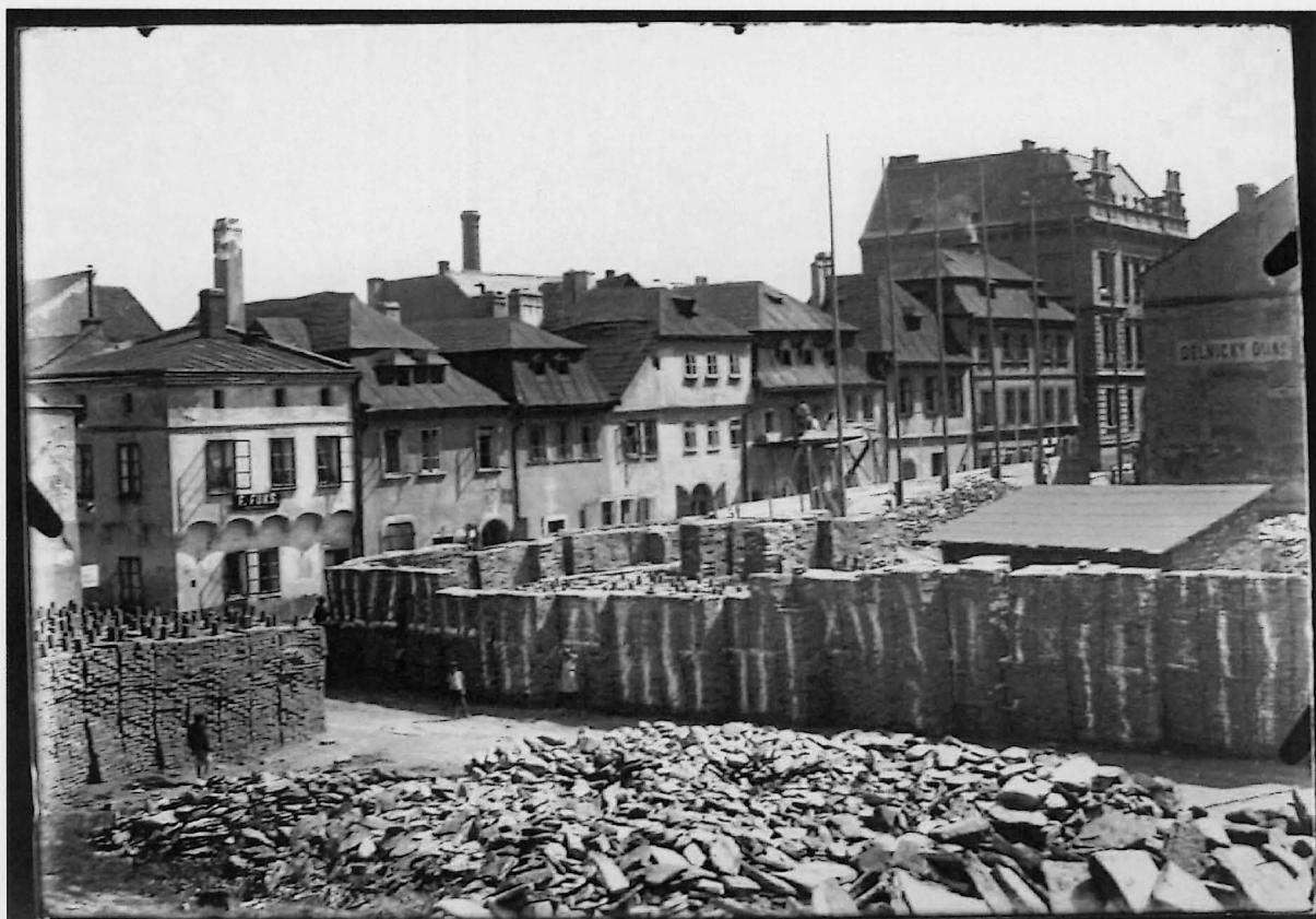
Ulice Karolíny Světlé a Na Hradbách, asanace v roce 1921.
