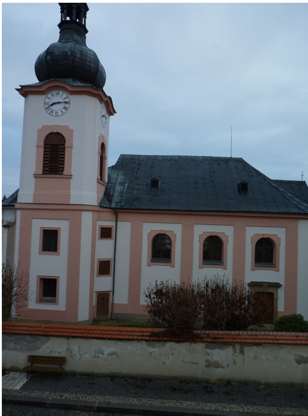
Kostel sv. Jana Křtitele po opravě (vlastní fotografie)
