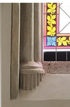
94. Milevsko, opatská kaple, sokl ostění okna, 60. až 80. léta 13. století. Foto: Petr Skalník
