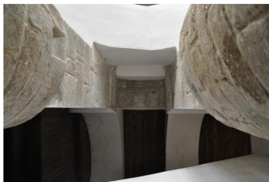
18. Milevsko , kostel sv. Jiljí, konec 12. století, románské sloupy, pilíře a na ně navazující arkády západní přístavby. Foto: autorka
