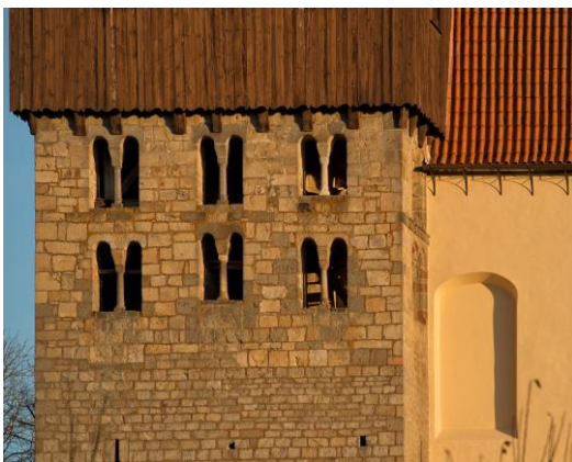
23. Milevsko , kostel sv. Jiljí, konec 12. století, západní věž, pohled od jihozápadu. Foto: Jan Vávra
