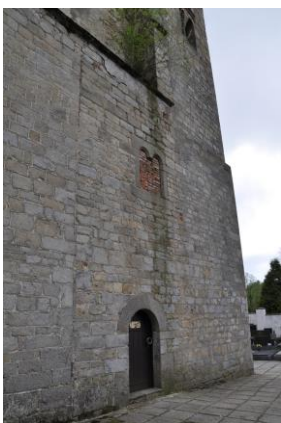
11. Milevsko , kostel sv. Jiljí, konec 12. století, spára ve zdivu mezi severní románskou zdí a západní věží, pohled od severovýchodu. Foto: autorka
