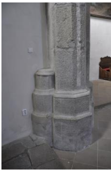
85. Milevsko, bazilika Navštívení Panny Marie, patka pásu triumfálního oblouku a klenební přípory, 60. až 80. léta 13. století. Foto: autorka
