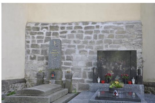
35. Milevsko , kostel sv. Jiljí, konec 12. století, úsek románského kvádového zdiva ve stěně gotické sakristie, pohled od severu. Foto: autorka
