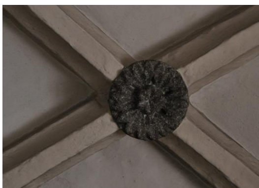
96. Milevsko, klenební svorník v místnosti nad opatskou kaplí, 60. až 80. léta 13. století. Foto: autorka
