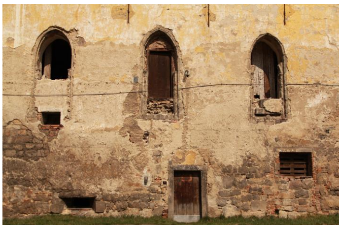
99. Milevsko , raně gotická okna refektáře, 60. až 80. léta 13. století, jižní stěna jižního křídla konventu, pohled od jihu. Foto: Petr Skalník
