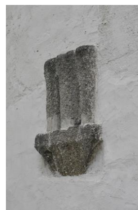
76. Milevsko , klenební konzola v nádvoří stěně baziliky, konec 12. až počátek 13. století. Foto: autorka
