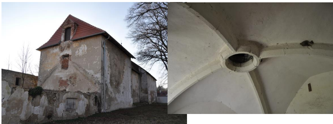
109. Milevsko , gotická věž a palác, první čtvrtina 14. století a druhá polovina 14. století, pohled od severovýchodu. Foto: autorka
