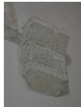
45. Milevsko , bazilika Navštívení Panny Marie, konec 12. až počátek 13. století, konzola na vnější straně jižní zdi mnišského chóru. Foto: autorka
