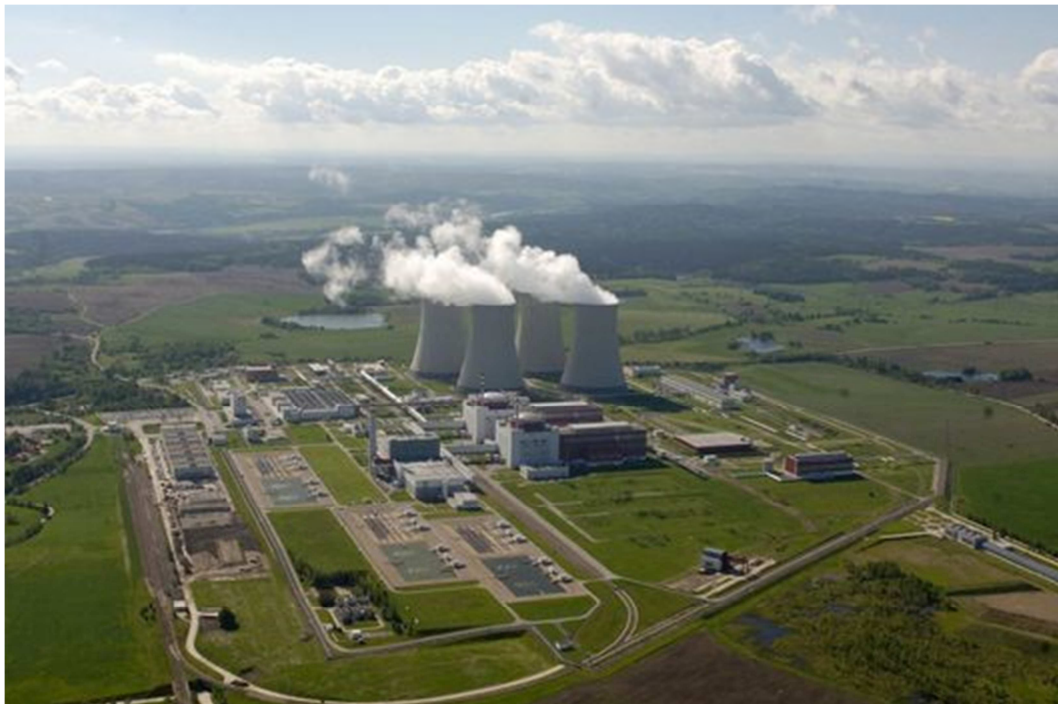
Obrázek č. 2 a 3 – Letecké snímky nad současnou podobou areálu jaderné elektrárny Temelín (Zdroj www.cez.cz )
