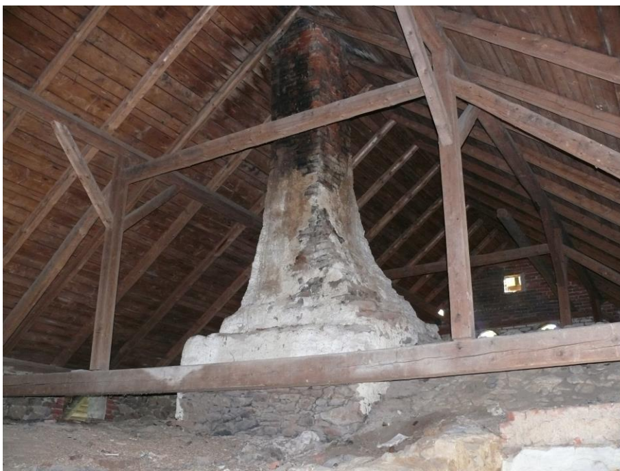
46) Nový Rounek čp. 14 (JI). Komín s dymníkovým ústím na klenbě kuchyně. Foto Ivan Minář, 2013.
