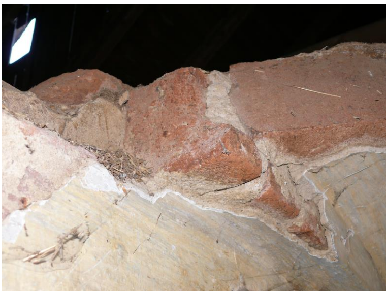
27) Nový Rounek čp. 14 (JI). Detail okraje klenebního pasu s cihelnou tvarovkou. Foto I. Minář, 2013.
