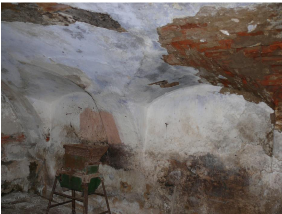
32) Bezděkov čp. 5 (JI). Stejný typ klenby použitý v chlívě domu z poloviny 19. století. Foto Ivan Minář, 2012.
