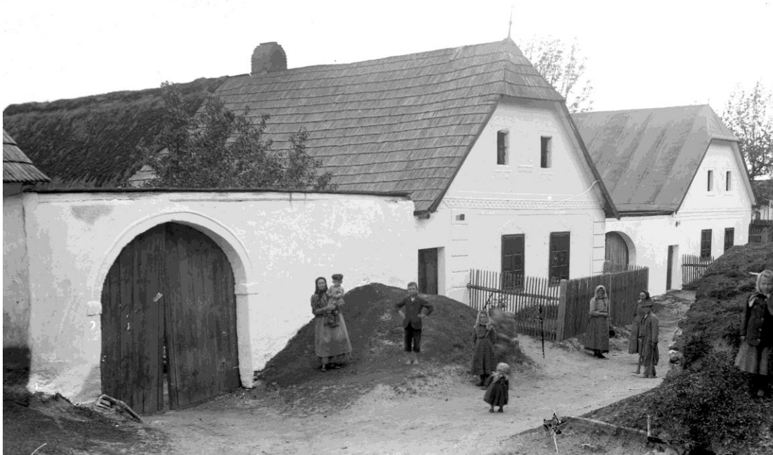
5) Historický snímek domů na návsi v obci Pavlov (II). Dům v popředí představuje typ zástavby z druhé čtvrtiny 19. století, zde dosud s původní šindelovou krytinou nad obytnou částí, došky nad chlévy a komínem s dymníkovým ústím. Okna světnice jsou zřejmě již dodatečně zvětšena. Obě průčelí jsou bohatě zdobená štukovým dekorem, který však podle snímku nelze kresebně rekonstruovat. Foto Ondřej Knoll, počátek 20. století, sbírka Muzea Vysočiny Třebíč.
