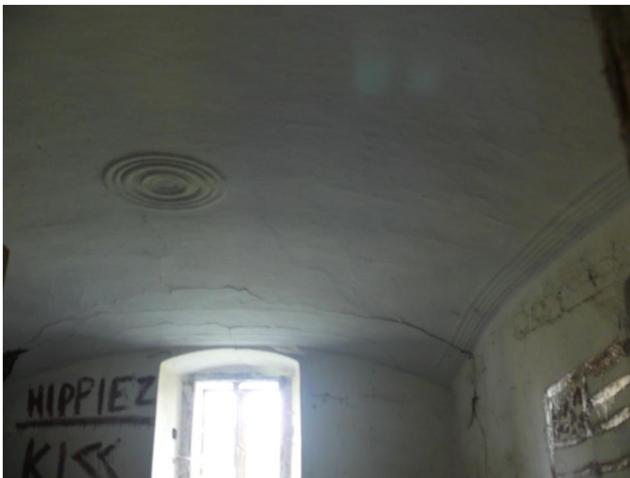
25) Macourov čp. 6 (HB). Téměř vodorovná placková klenba nad komorou domu s datací 1873 je dílem stavitele Václava Bence. Všechny klenby v domě jsou dekorovány štukovým terčem nad středem a profilací po obvodu. Jedná se o poslední generaci plackových kleneb před tím, než byly koncem 19. století nahrazeny segmentovými klenbami. Foto Ivan Minář, 2013.
