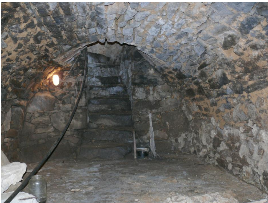
30) Nová Ves čp. 22 (JI). Valená klenba sklepa je klenutá ze sbíraného kamene spojovaného jílem. Foto Ivan Minář, 2014
