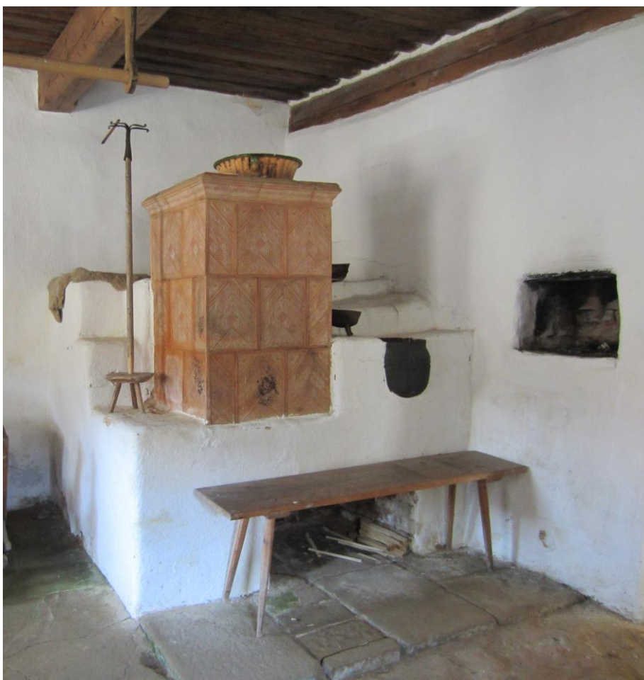
41) Pohled čp. 16 (HB). Sestava vytápěcích zařízení ve světnici, běžných v první polovině 19. století. Vyhřívací nepřímo obsluhovaná kamna odpovídají typem kachlů zhruba roku 1800. V jejich šíři je vsazen kamnovec a ve stěně vpravo osvětlovací krbeček na svícení loučemi. Pec i kamna jsou obsluhovány z černé kuchyně za stěnou. Foto Silva Jagošová, 2015.
