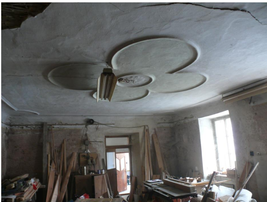
21) Telč – Staré Město čp. 55 (JI). Omítaný strop světnice zdobený štukovými kružnicovými motivy. Dům nese dataci 1805, ale tato úprava odpovídá, i vzhledem k velikosti oken, spíše mladší úpravě z poslední třetiny 19. století. Foto Ivan Minář, 2014.
