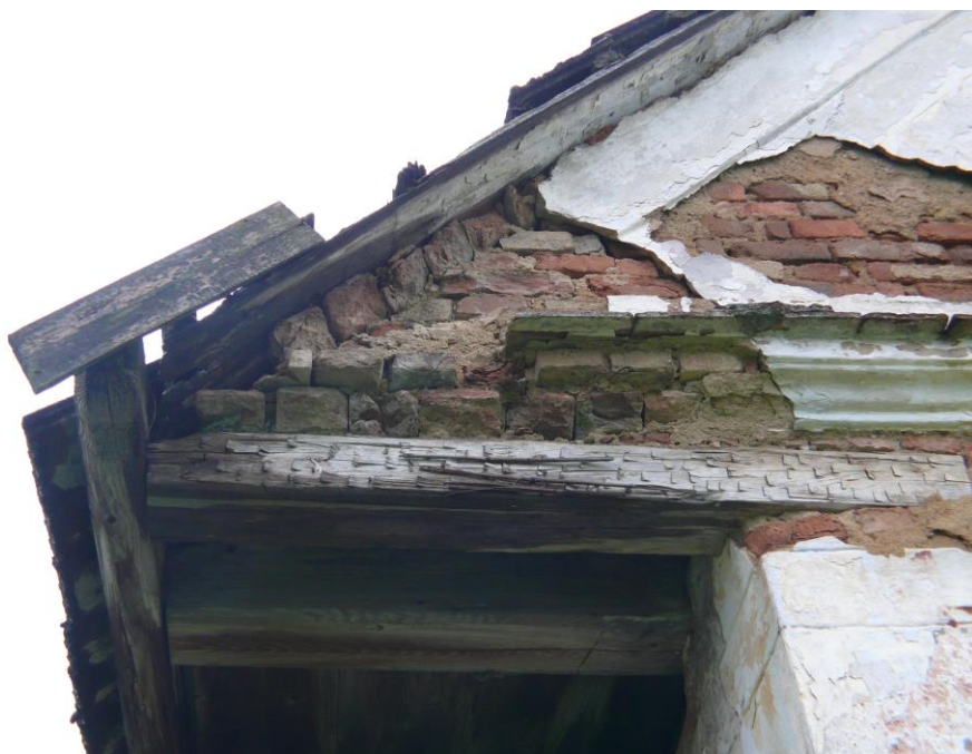
17) Rynárec čp. 14 (PE). Detail trámku vynášejícího přesah štítové stěny nad zápražím domu. Dřevěná konstrukce, překrytá původně štukem, pochází ze 40. let 19. století. Foto Ivan Minář, 2014.
