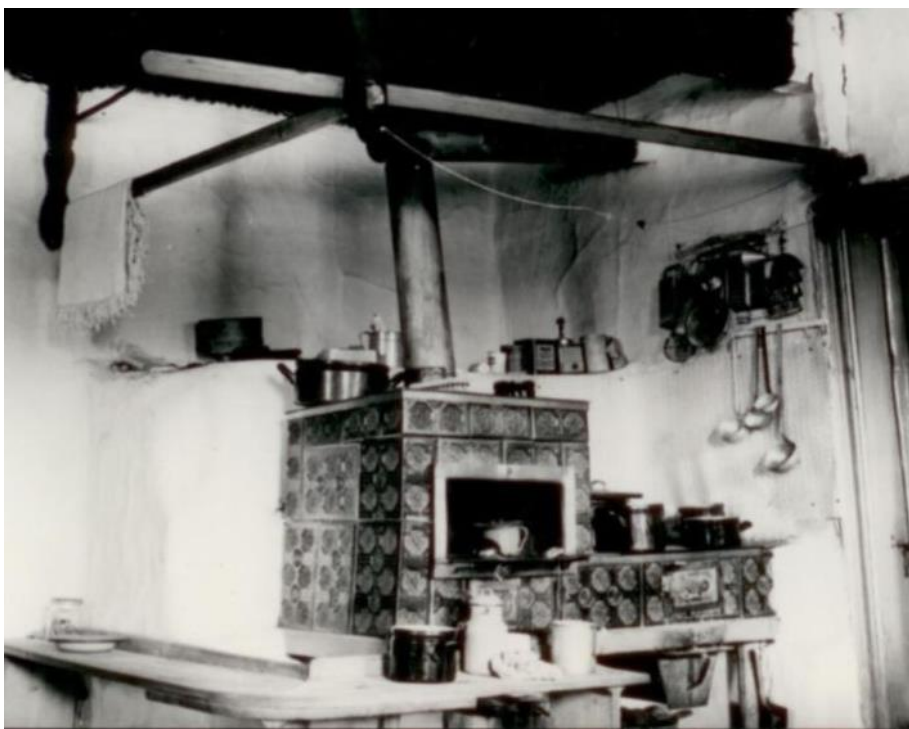
42) Daňkovice čp. 47 (ZR). Sporák ze třetí čtvrtiny 19. století s přímým přikládáním a kouřem vyvedeným rourou pod otevřené ústí komínu v černé kuchyni za stěnou. První sporáky byly umísťovány na tradičním místě kamen a v některých případech byly k jejich stavbě použity i starší kachle. Foto z roku 1970, archiv NPÚ v Telči.
