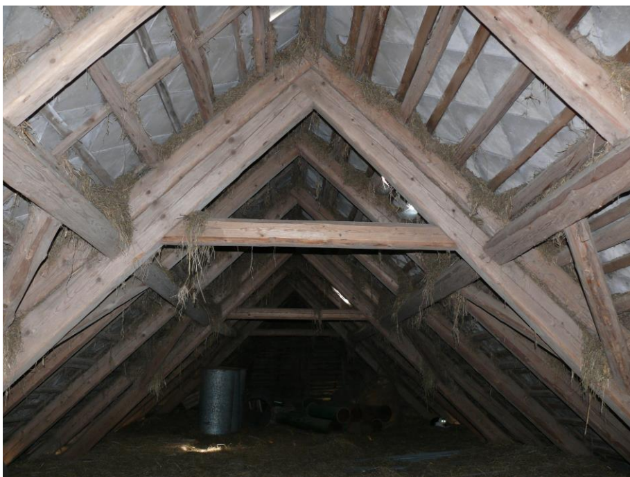
39) Horní Dubenky čp. 28 (JI). Krov nad kolnou je pozdější variantou Ránkova krovu s protažením sloupků až do hřebene. Foto Ivan Minář, 2014.
