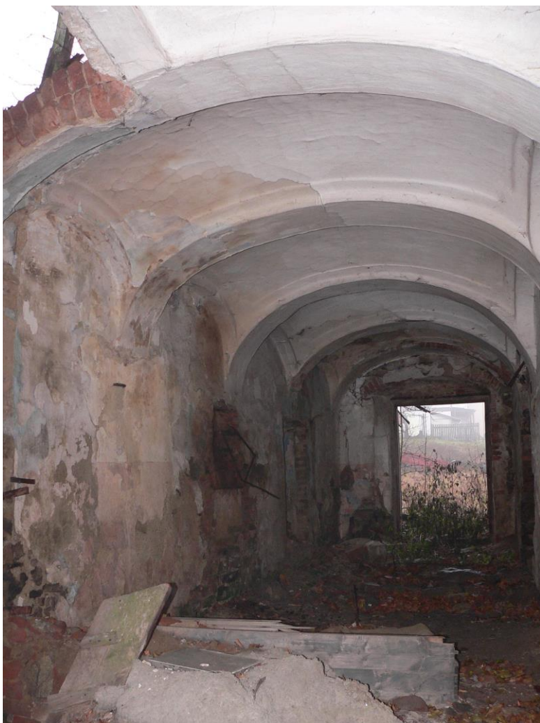
24) Hlávkov čp. 1 (JI). Řada plackových kleneb v průchozí síni pochází zřejmě z druhé třetiny 19. století. V levém horním rohu snímku býval průstup klenbou na půdu. Foto Ivan Minář, 2009.
