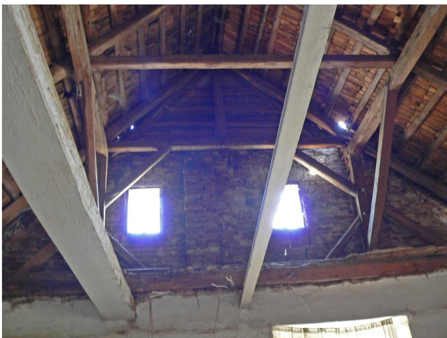
36) Jihlávka čp. 61 (JI). Běžný hambalkový krov se dvěma stojatými stolicemi z první poloviny 19. století, dosud krytý šindelem. Detail poslední vazby ve štítě pod valbičkou. Foto Ivan Minář, 2009.
