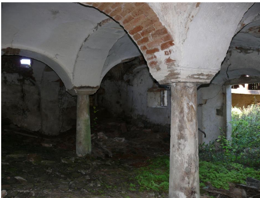
26) Nový Rounek čp. 14 (JI). Klenbu chléva z poloviny 19. století tvoří šest polí plackových kleneb do pasů podpíraných kamennými sloupy. Foto Ivan Minář, 2013.
