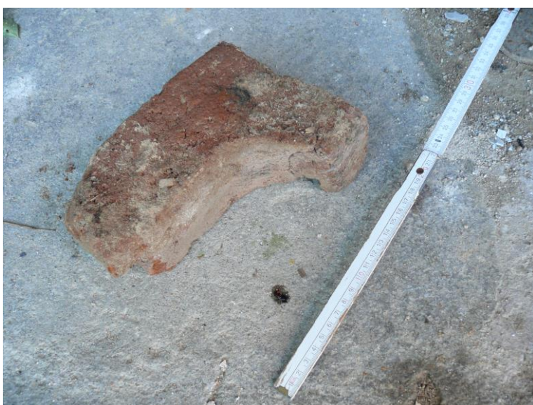
28) Nový Rounek čp. 14 (JI). Detail cihelné tvarovky použité v pasech. Foto Ivan Minář, 2013.
