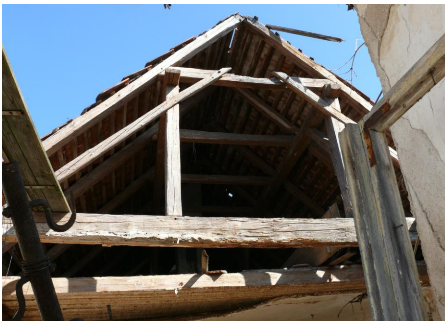
19) Lhotice čp. 24 (TR). Hambalkový krov spojený ještě se stropní konstrukcí. Vazný trám zde je jedním ze stropních trámů, krytých zespodu omítaným rákosovým podhledem. Horní pochozí vrstvu tvoří hliněná mazanina. Dům zdobený volutovým štítem byl postaven kolem poloviny 19. století. Foto Ivan Minář, 2012.
