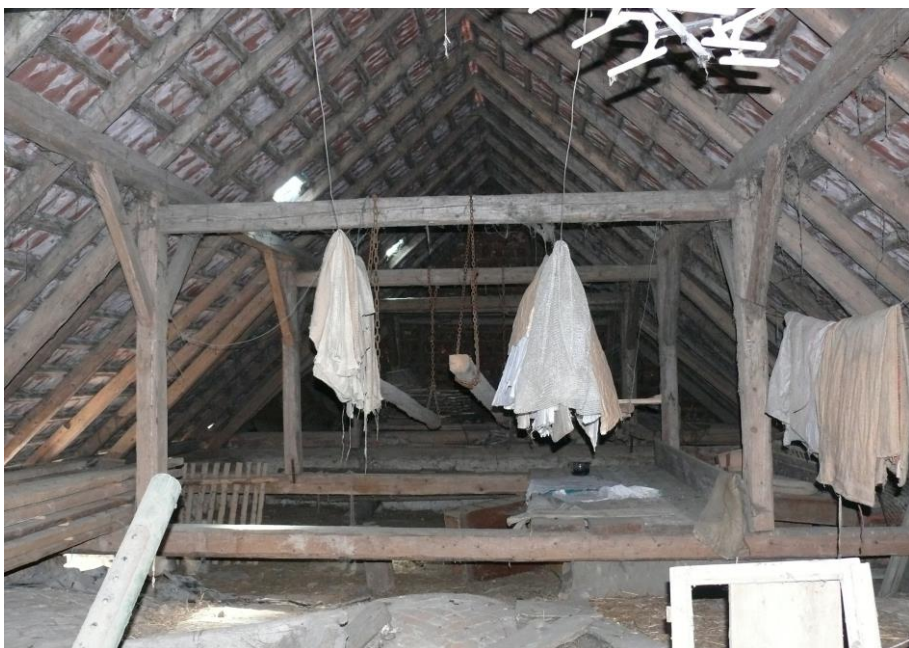
40) Čechtín čp. 12 (TR). Vaznicový krov nad hospodářskou částí domu z přelomu 19. a 20. století. Krokve jsou již dimenzovány na taškovou krytinu. Foto Ivan Minář, 2014.
