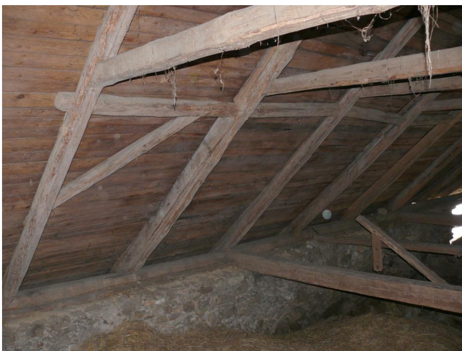
33) Simtany čp. 20 (HB). Jednoduchý hambalkový krov, jehož podélné ztužení zajišťují pouze trámky mezi krokvy. Foto Ivan Minář, 2014.
