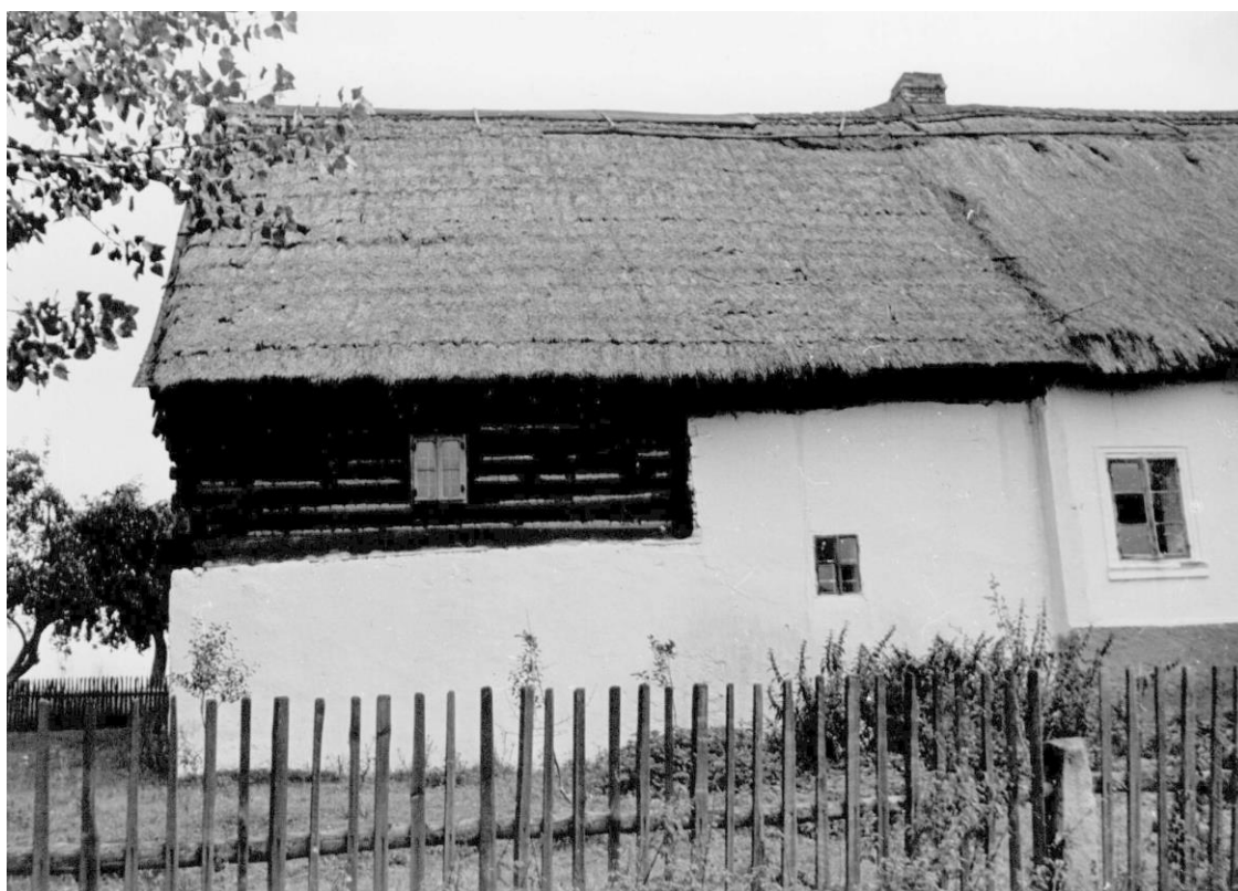
4) Historický snímek domu v Dlouhé Vsi (HB) s roubenou světnicí připojenou ke zděnému jádru. Objekt představuje typ venkovské zástavby z přelomu 18. a 19. století. Na pravé straně je již vidět později přestavěná část s větším oknem. Došková krytina zjevně sloužila až do poloviny 20. století, kdy byl snímek pořízen. Foto Hellegger, fototéka NPU GnŘ.
