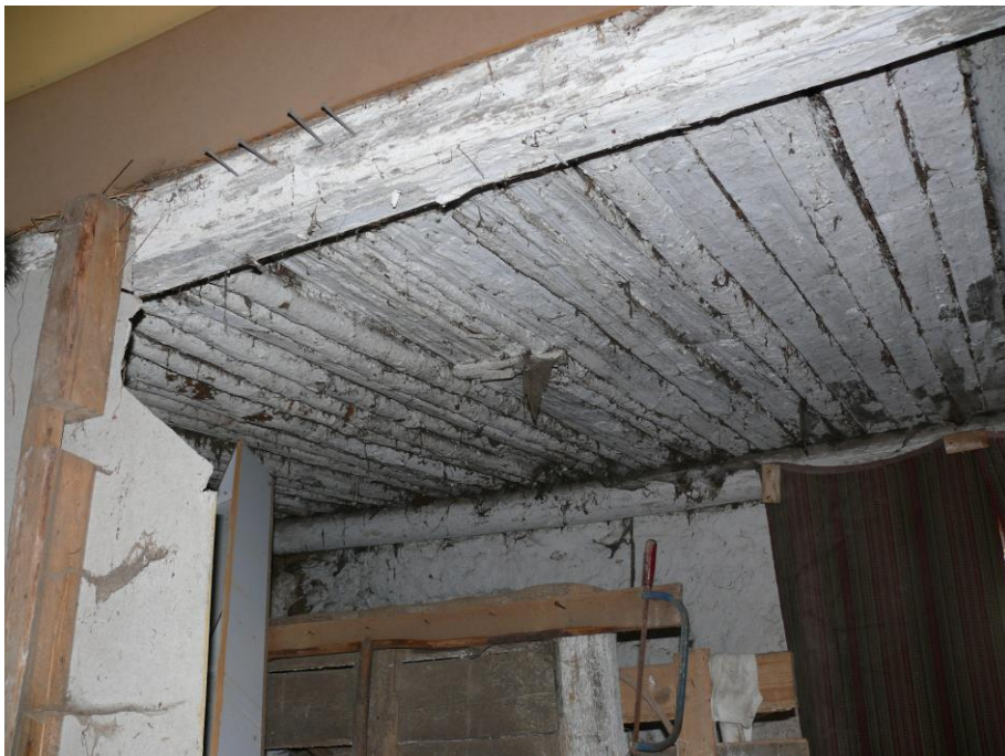
20) Nová Buková čp. 7 (PE). Povalový strop nad hospodářskou částí domu je archaicky obnažený a pouze bílený. Oproti stropům v obytných částech zde chybí horní vrstva hliněné mazaniny. Foto Ivan Minář, 2014.
