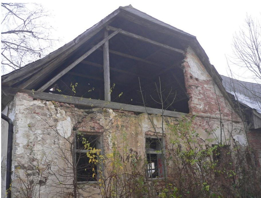
35) Hlávkov čp. 1 (JI). Vysoký hambalkový krov s dvojicí stojatých stolic z druhé třetině 19. století. Foto Ivan Minář, 2009.
