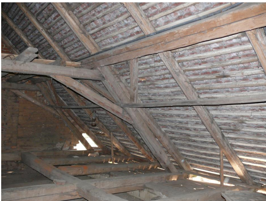
38) Nová Ves čp. 22 (JI). Ránkův krov ze 60.–70. let 19. století. Detail sloupku ležaté stolice s výměnou nad zápražím. Foto Ivan Minář, 2014.
