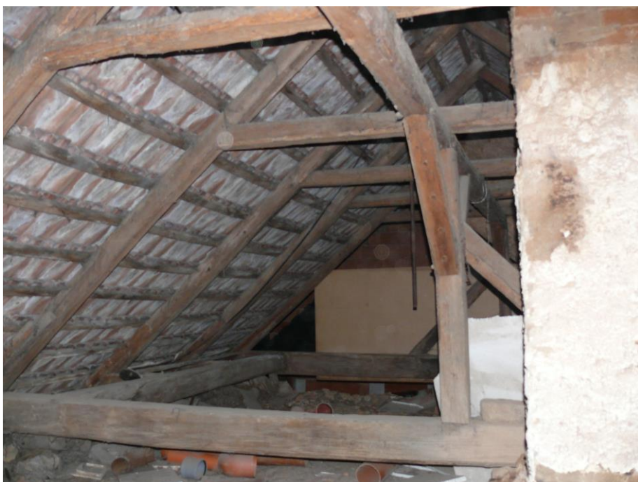
34) Batelov čp. 22 (JI). Hambalkový krov s jednou stolicí nese taškovou krytinu. Foto I. Minář, 2015.
