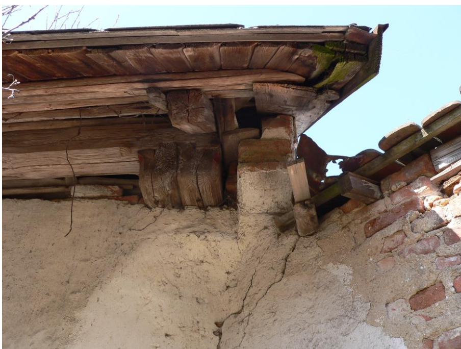
37) Jihlávka čp. 61 (JI). Detail zakončení přesahu střechy nad zápražím. Foto Ivan Minář, 2009.
