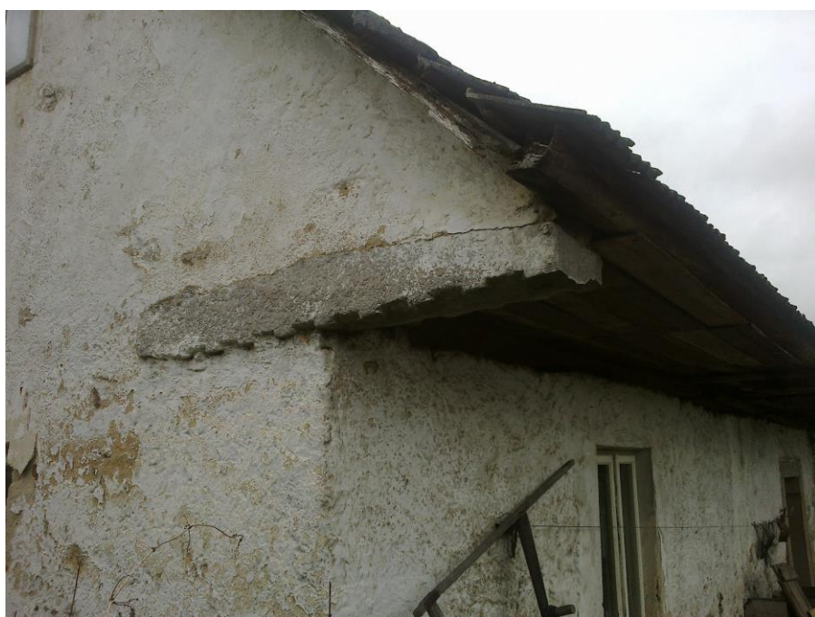
18) Zahrádky čp. 66 (JH). Tentýž detail přesahujícího štítu vyřešený kamennou konzolou. Dům z poslední čtvrtiny 19. století náleží k chudší domkářské zástavbě. Foto Ivan Minář, 2015.
