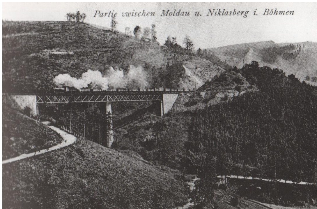
Obrázek 8 Viadukt nad Mikulovským údolím, vystavěný v letech 1883–1884, na pohlednici z roku 1910. Pro svou konstrukci a citlivé začlenění do krajiny byl prohlášen za technickou památku. Zdroj: Budínská a kol., 1994: s. 57.
