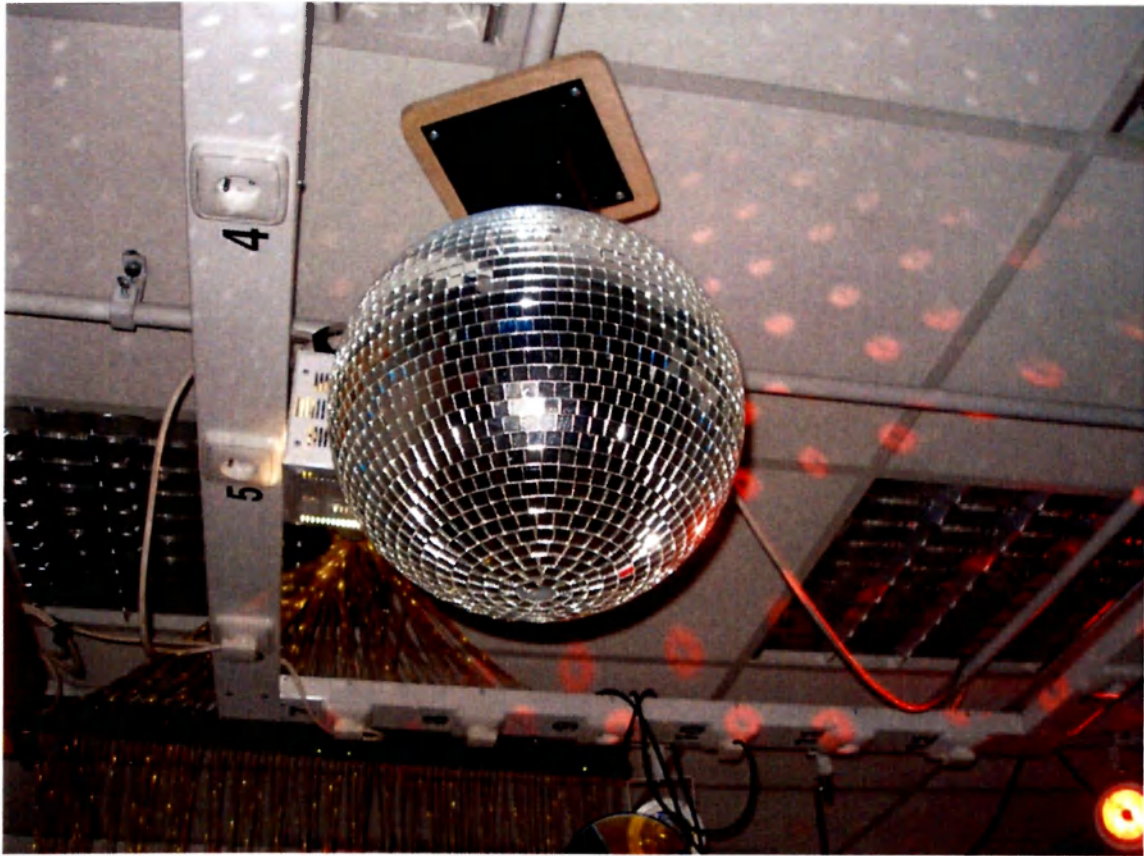
Pohled na strop (stroboskop a kovová konstrukce se zásuvkami pro zapojení jednotlivých efektů)
