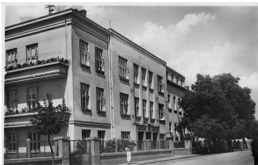
36. Užhorod, Malé Galago, 20.–30. léta 20. století, budova nemocnice
