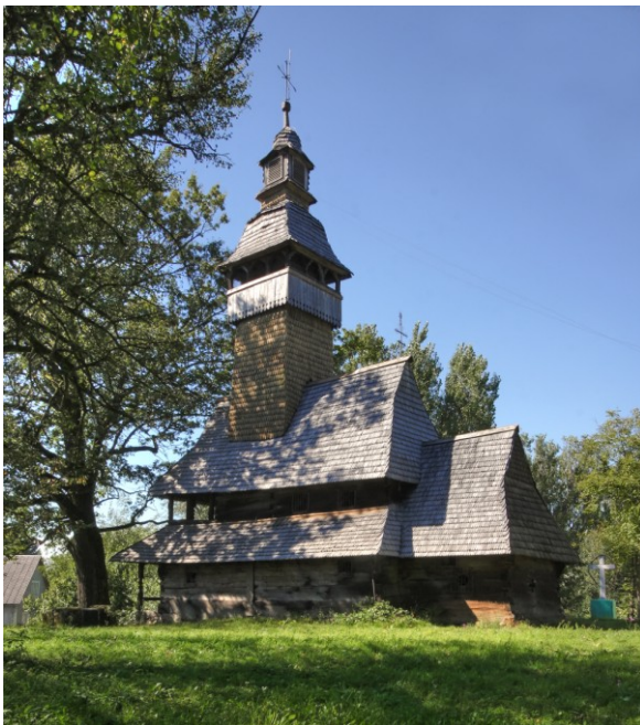
15. Kolodne, kostel sv. Mikuláše, 15.století, pohled od jihu
