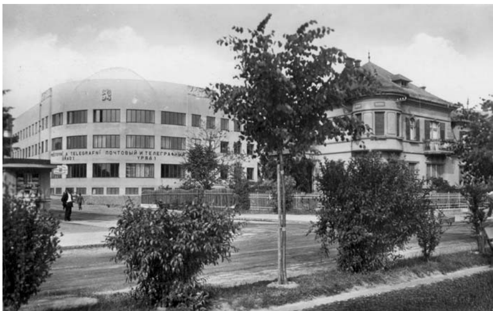
38. Užhorod, Malé Galago, 1928–1930, poštovní úřad podle projektu arch. Gočára
