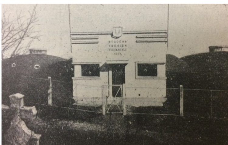
58. Užhorod, vodojem města Užhorodu, 1929–1931, podle projektu arch. Oelschlägera
