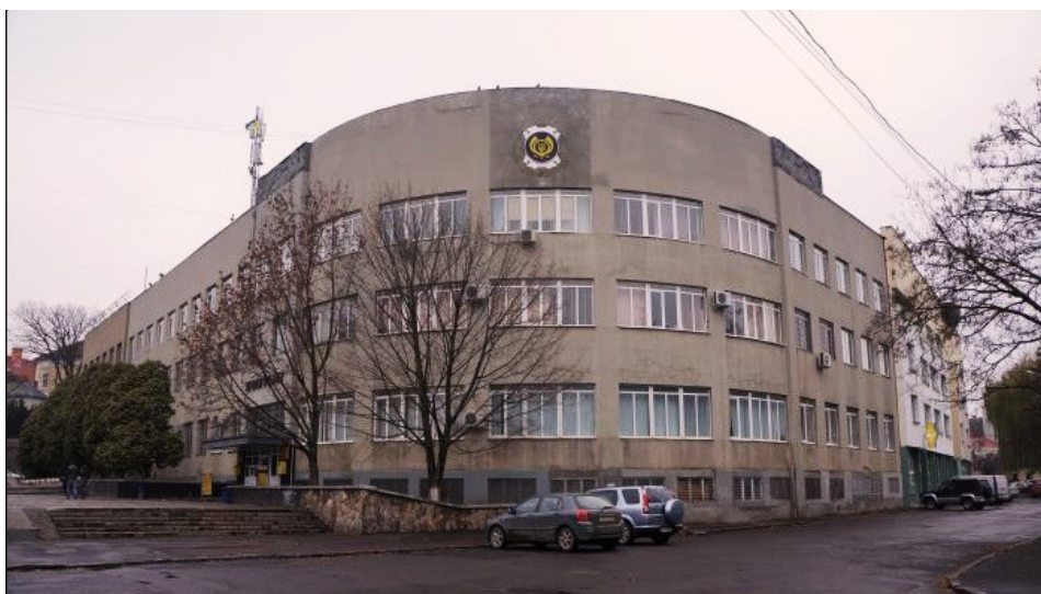
39. Užhorod, Malé Galago, 1928–1930, poštovní úřad podle projektu arch. Gočára.
