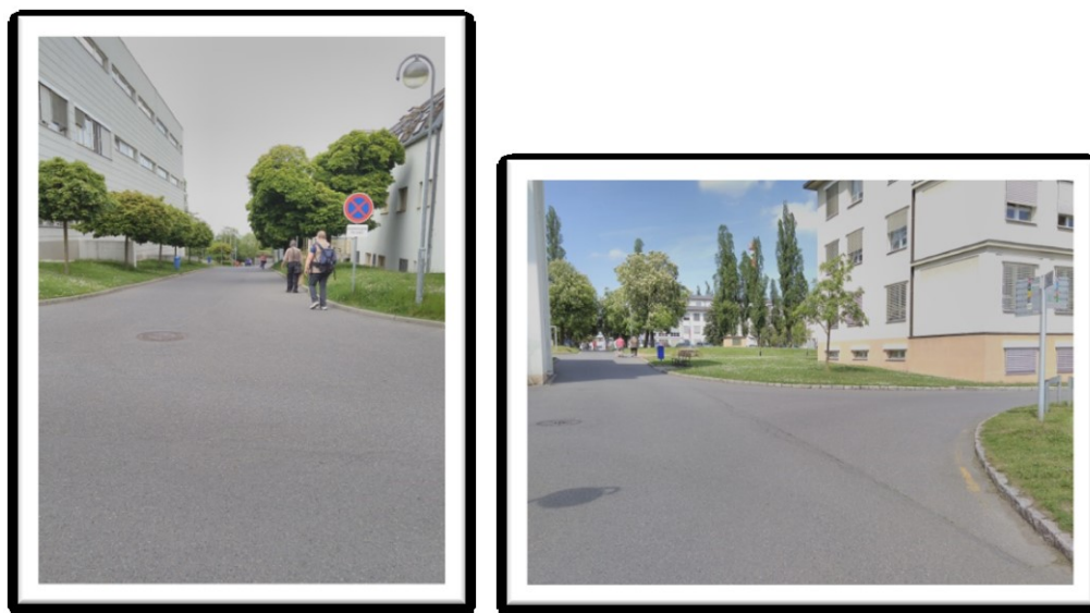
Obrázek č. 12 a 13: Chybějící chodníky v areálu (zdroj: autorka)
