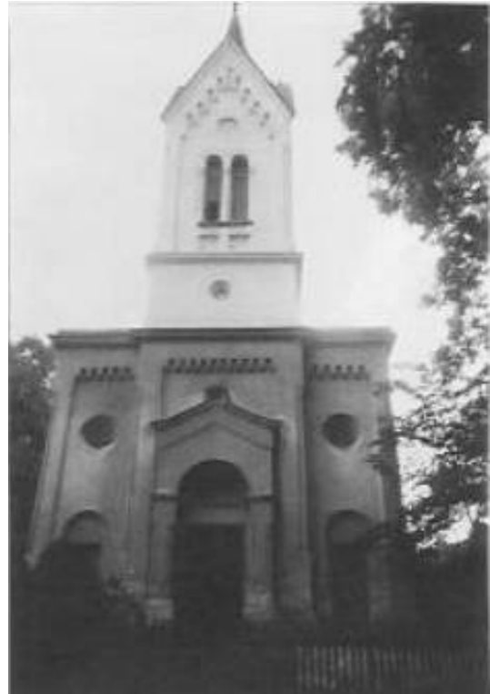
Opatovice, kostel a. v.
