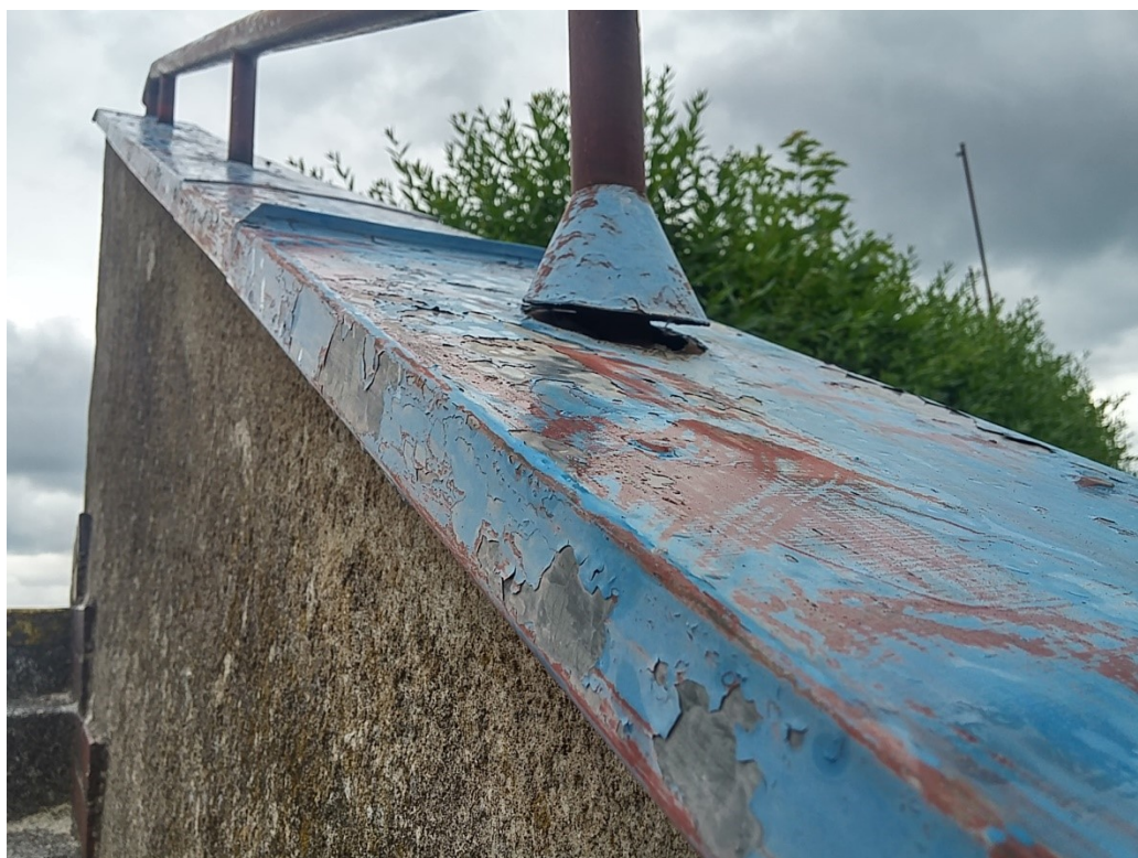
Příloha č. 5: oprava uvolněných částí zábradlí a jejich nátěr
